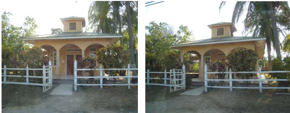
Imagen 8-3. 6. Fotografía Sistema constructivo Madera, Iglesia Católica de Isla de Chira, técnica constructiva con cerramientos de madera, utilización de parrillas y monitores para el tratamiento de la ventilación interior.
