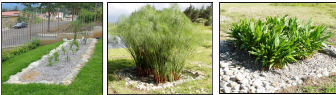
(a) (b) (c) Figura 4-2.13 (a) Jardinera al inicio de su funcionamiento para el tratamiento de aguas grises, (b) y (c) Jardineras en funcionamiento.
