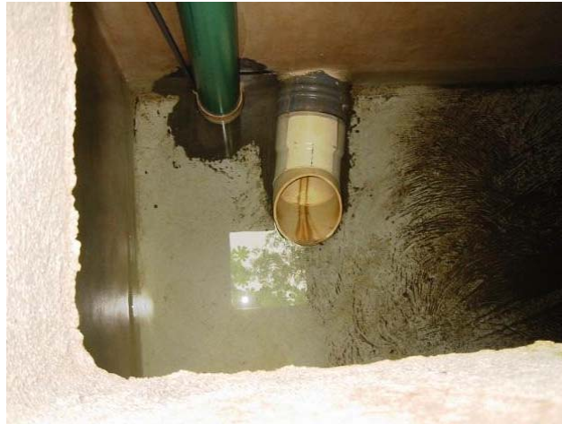
Fotografía 4-1.3. Interior del tanque de San Pablo con sedimentos en el fondo. Fuente: ICAA, 2005.
