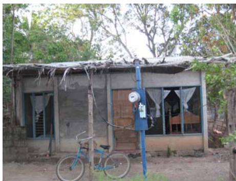
Imagen 8-3.1 Fotografía casa de habitación que ejemplifica las características de las edificaciones con tipología arquitectónica 1.
