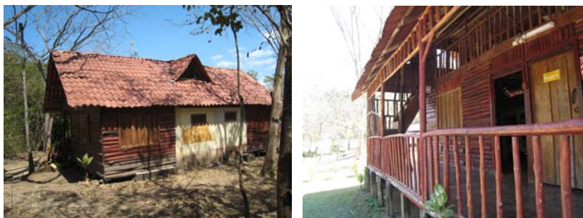
Imagen 8-3. 4. Fotografía Sistema constructivo Mixto, Alberque de Damas de Isla de Chira, utilización de desechos de troncos de madera (teca) como elemento de cerramiento principal, cubierta de teja metálica, adecuado manejo de técnicas de climatización pasiva en la edificación, utilización de pilotes y monitores para mejor manejo de la ventilación.
