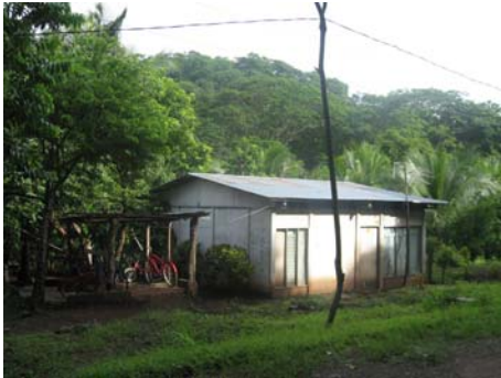
Fotografía 4-3.1 Posteo eléctrico deficiente en algunos sectores de la isla
