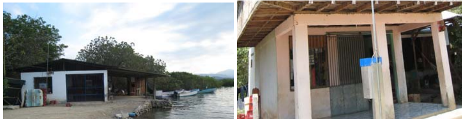
Imagen 8-3. 3. Fotografía Sistema constructivo de concreto, Pescadería de Palito y Cabinas Las Vegas.
