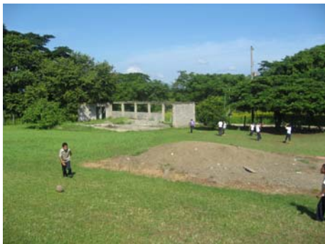
Fotografía 6-6.2 Obra de construcción suspendida en la escuela “Montero y Palito”
