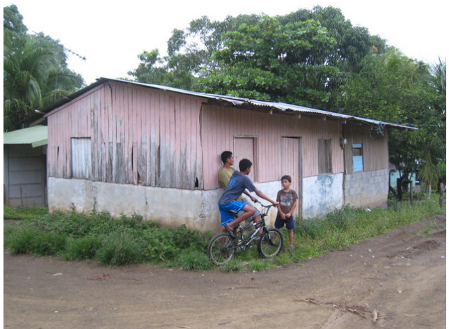
Fotografía 3-1.14 Vivienda en Palito. Se observa la falta de aceras y drenajes.
