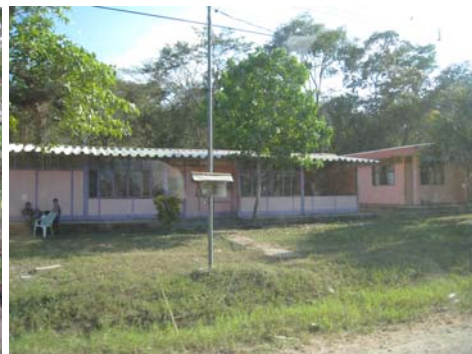
Imagen 8-3.2 Fotografía Sistema constructivo bloques prefabricados, EBAIS en Bocana.
