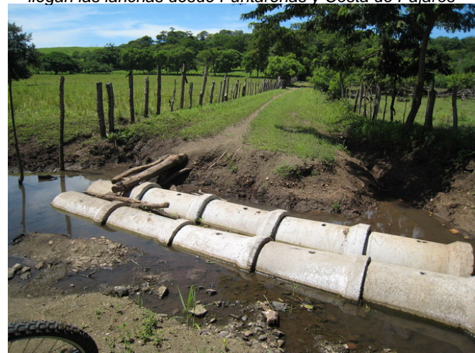
Fotografía 3-1.12 Sección de calle con necesidad de un puente en Jícaro
