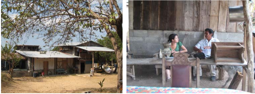
Imagen 8-3. 5. Fotografía Sistema constructivo Mixto, Casas de Habitación en Bocana y Playa Muerto, Esta técnica constructiva es a base de zócalos de bloques de concreto y cerramientos de madera o ply Wood en algunos casos.
