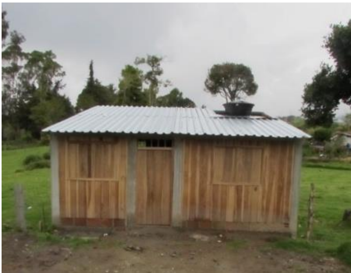
Figura 67. Vivienda de interés prioritario en lote propio construida por la alcaldía de Murillo Tolima. Foto: Luis Hernández
