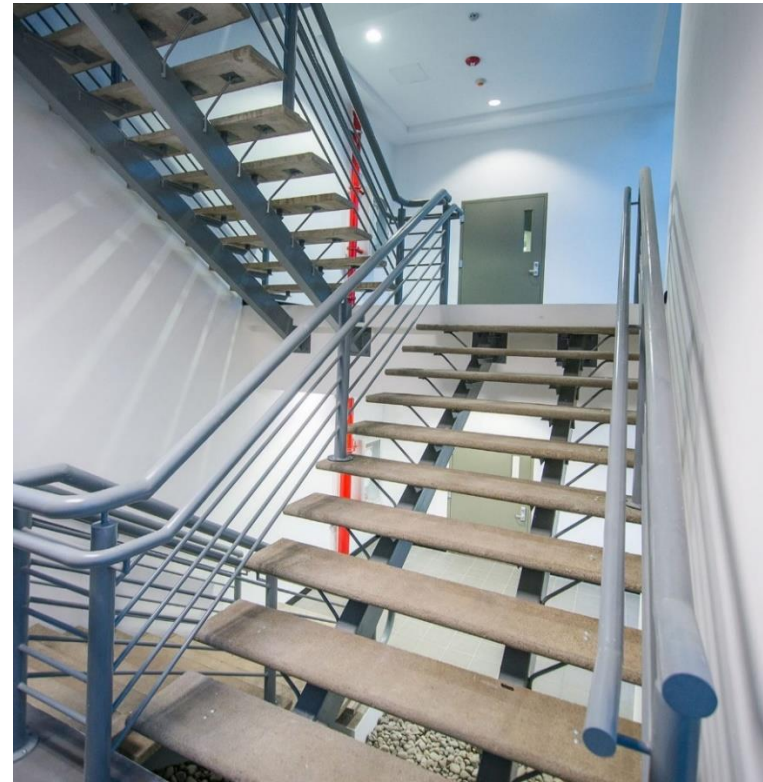
Figura 2.67 Escaleras de emergencias en el edificio de la Escuela de Tecnologías en Salud. (Facebook TS, 2018)
