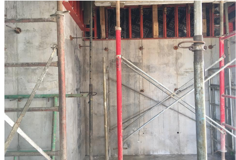
Figura 2.49 Muros de concreto en obra en Edificio de Tecnologías en Salud de la UCR. (OEPI, 2017)
