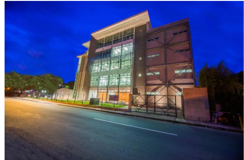
Figura 2.63 Pantalla acústica en fachada Norte del edificio de la Escuela de Tecnologías en Salud de la UCR vista desde la calle. (Facebook TS, 2018)
