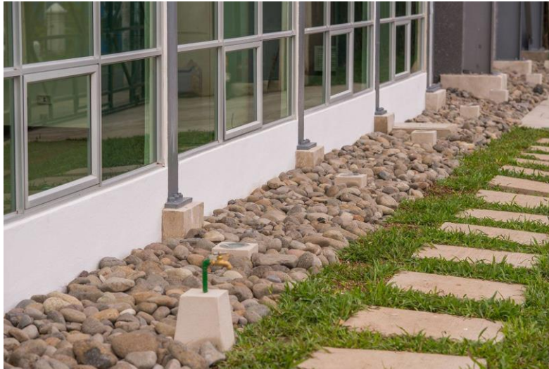
Figura 2.46 Imagen ilustrativa de provisiones de tubería de agua potable, Edificio de Tecnologías en salud de la UCR. (Facebook TS, 2018)
