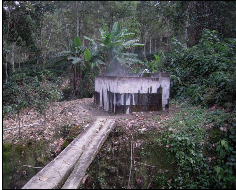
Fig. 60: Tanque de captación principal en la Finca Chúcaras en el sitio de muestreo BE-28.
