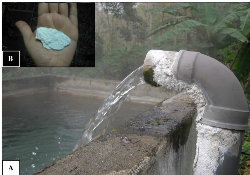
Fig. 61: A) Precipitados de apariencia carbonatada en el tubo de la captación de agua termal en la finca las Chúcaras. B) Detalle del precipitado sólido.
