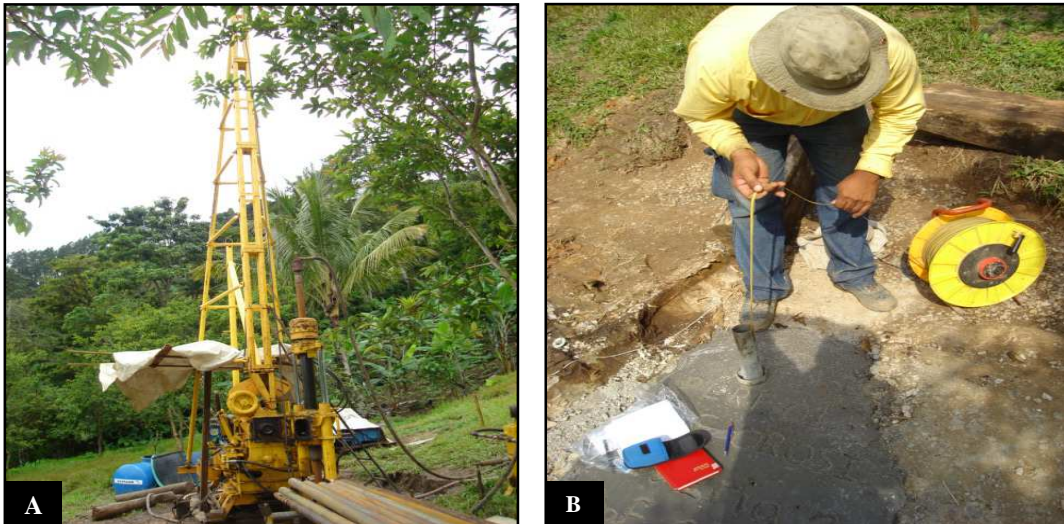
Fig. 66: A Ubicación de máquina perforadora del ICE, en condiciones superficiales similares al sitio BE - Z21, ubicado en la parte con vegetación al fondo. B Detalle de medición de nivel del agua en el pozo.
