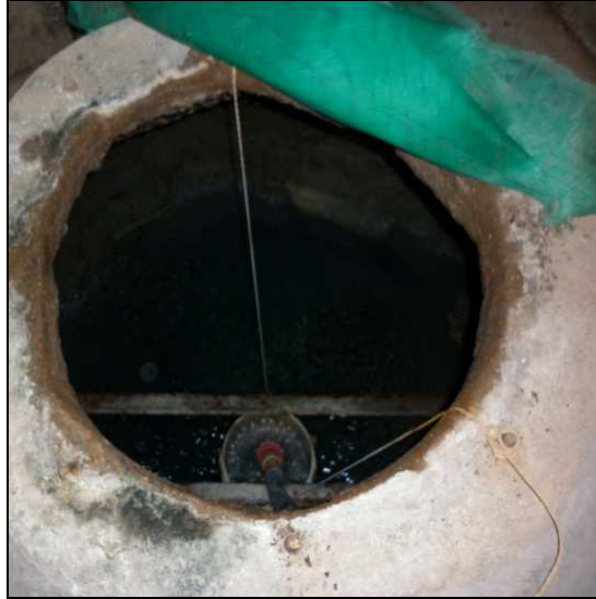
Fig. 64: Pozo artesanal en plena explotación para aprovechar recurso geotérmico en aplicaciones directas en el “Balneario los Patios”.
