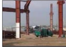
Recorrido de la grúa.
