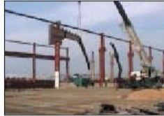
Recorrido de la grúa.
