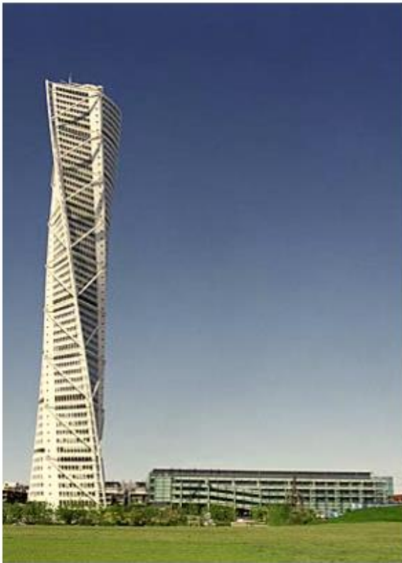
Ilustración 102. Arriostramiento en el edificio Turning Torso - Torre en espiral de 190m. Mälmo, Suecia. Fuente: Serrano, M. M. Cap. XI. Obtenido del informe ARRIOSTRAMIENTO 2015
