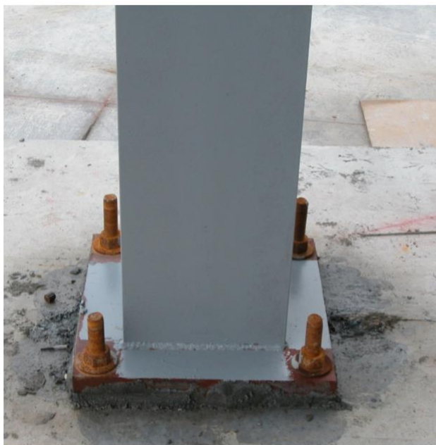
Ilustración 31. Fotografías de placas base-columna. Fuente: Alacero. Conexiones base-columna
