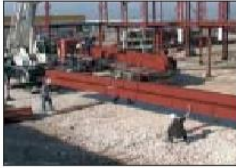
Descarga de piezas.
