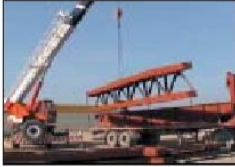
Izado de la carga.
