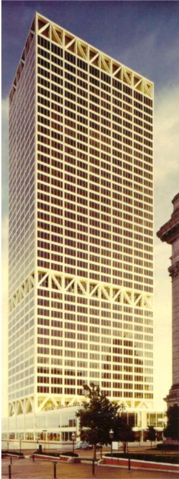
Ilustración 100. Arriostramiento en el edificio First Wisconsin Center, Milwaukee, USA, 1974. Fuente: Serrano, M. M. Cap. XI. Obtenido del informe ARRIOSTRAMIENTO 2015
