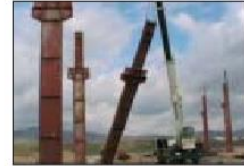
Recorrido de la grúa.
