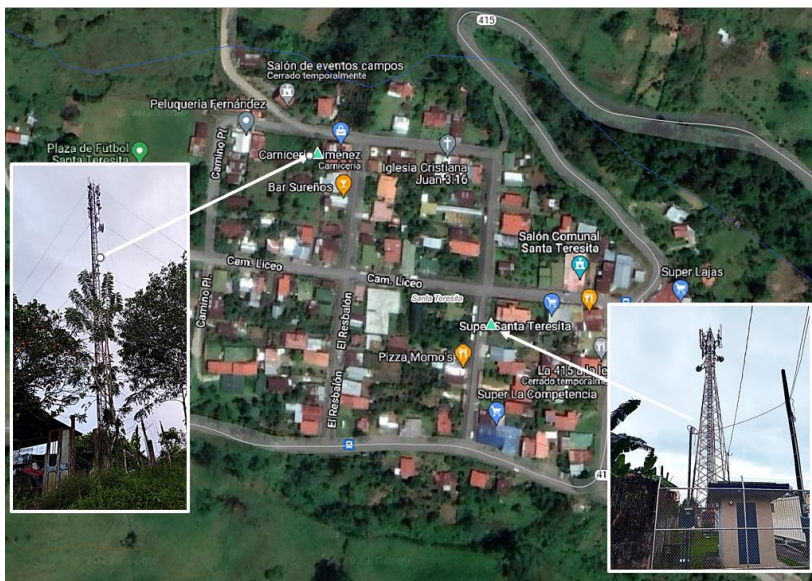
Imagen 17. Poblado de Santa Teresita, con marcas verdesse observa la ubicación de las torres en medio del poblado. Esta torre cuenta con una altura de 50m, el operador de dicha torre es el ICE y fue instalada en el año 2009.
