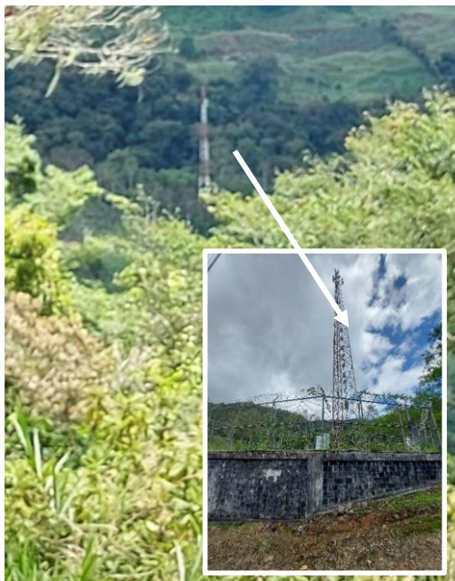
Imagen 15: En la fotografía principal se observa la torre en el sector de Pacayitas, se puede observar la vegetación alrededor de ella. En la segunda imagen se observa el sitio de la torre en donde se ve que realmente no está tan rodeada de vegetación es más en los alrededores de esta lo que se observan son cafetales y algunos árboles dispersos que no sobrepasan la altura de la torre
