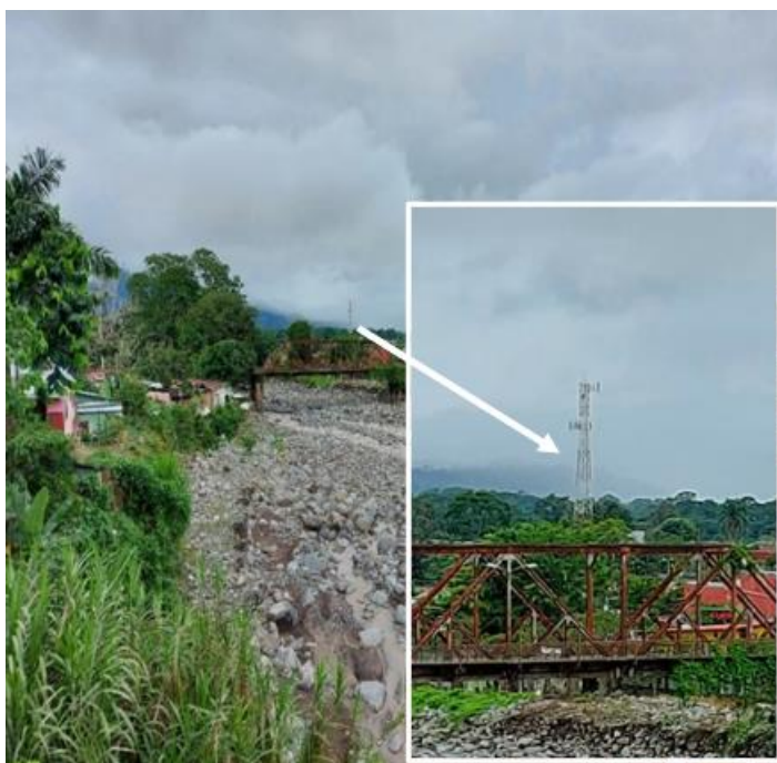
Imagen 07 Fotografías de torres de telecomunicación tomadas en campo: Foto del Río Turrialba tomada desde el puente Blanco hacia el puente “negro” antiguo puente del ferrocarril, al fondo se puede visualizar una torre de telecomunicación (aproximadamente a 760m dirección sureste del sitio donde se tomó la foto), en la foto se puede apreciar el material que arrastra el río, arenas y conglomerados, mismos que conforman los terrenos de este sector.
