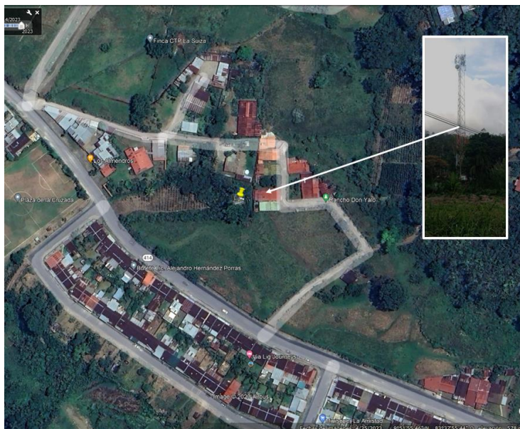
Imagen 36. Imagen de la ubicación de la torre en el poblado de La Cruzada, en ella se observa la vegetación alrededor de la estructura. (fuente: imagen de Google Earth)
