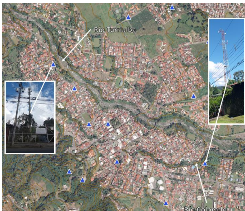
Imagen 27. Se observa la ubicación de las torres con respecto a los ríos Turrialba y Colorado, que fueron los cuerpos de agua involucrados en la inundación, de julio del 2021. Fuente Ortofoto 2017, SNIT.
