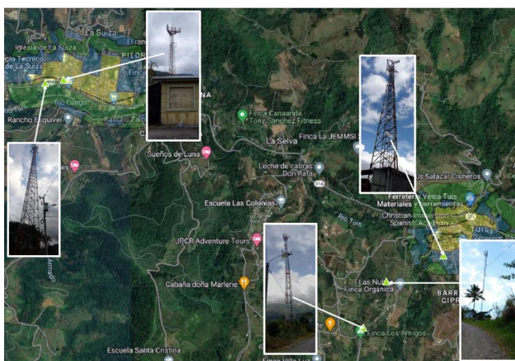
Imagen 40. Imagen de las torres en el sector Tuis, las mismas se ubican en áreas con un uso urbano, así como 2 torres cerca de Tuis, que se ubican cerca del camino vecinal y que en los alrededores se identifica el uso rural, con la presencia de potreros y cultivos. (fuente: imagen de Google Earth)
