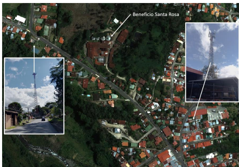
Imagen 22. Torres de telecomunicación en el poblado de Santa Rosa, en la imagen se observa el uso urbano del entorno. Fuente Ortofoto 2017, SNIT.
