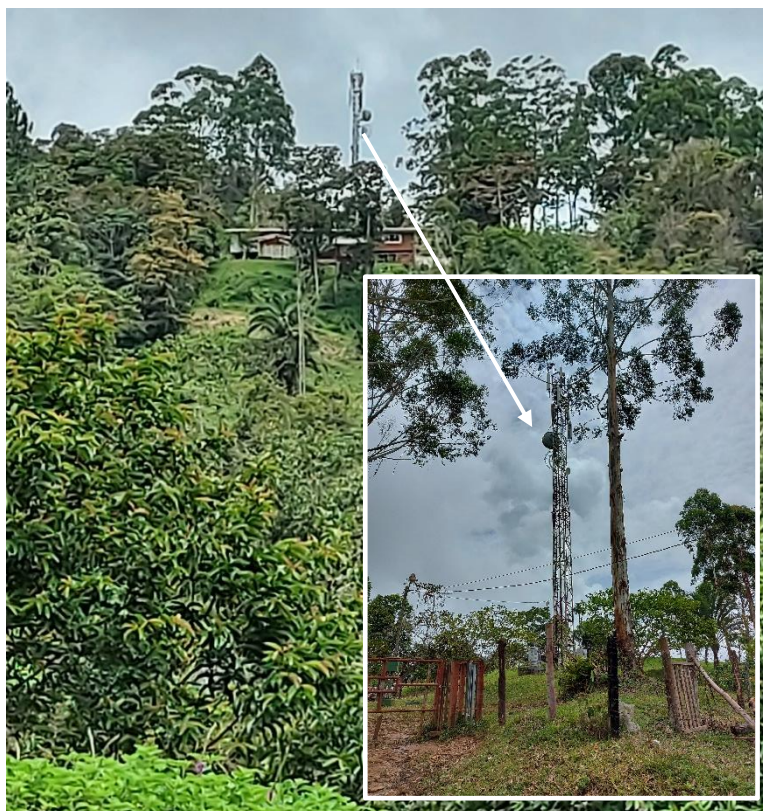
Imagen 13: En la fotografía principal se observa la torre en la parte alta de Grano de Oro, se puede observar la vegetación alrededor de ella. En la segunda imagen se observa una fotografía cercana al sitio en donde se ubica la torre, en ella se observa que la pendiente no es tan fuerte como se podría uno imaginar al ver la primera fotografía, esta torre fue instalada en el año 2009.
