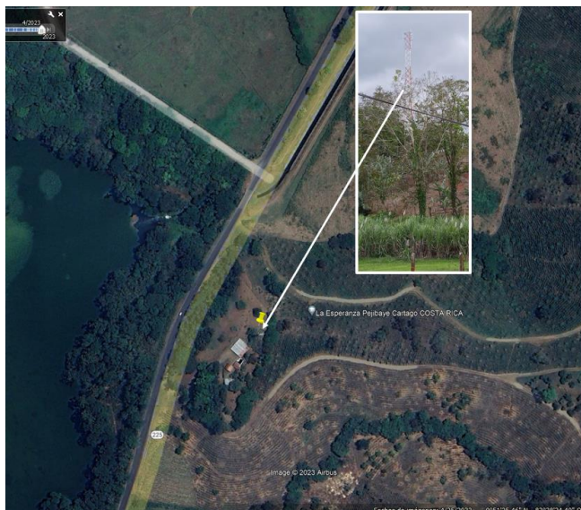
Imagen 37. Torre instalada entre La Cruzada y Atirro, ruta N° 225, en la imagen adjunta se observa la torre en un cerro, lo que amerita mantener vigilancia en la estabilidad de los terrenos en donde se ubica la torre. (fuente: imagen de Google Earth)
