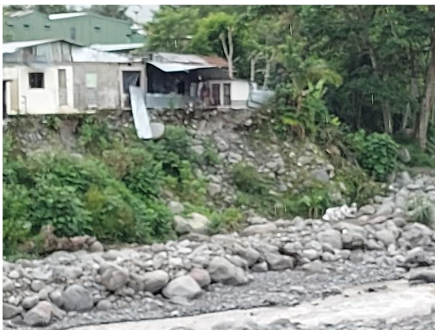
Imagen 05 Fotografía de la margen del Río Turrialba, en el que se pueden observar los materiales laháricos de los terrenos cercanos. En la imagen se ven algunas de las propiedades que se vieron afectadas por los eventos del Río Turrialba en el mes de julio del 2021
