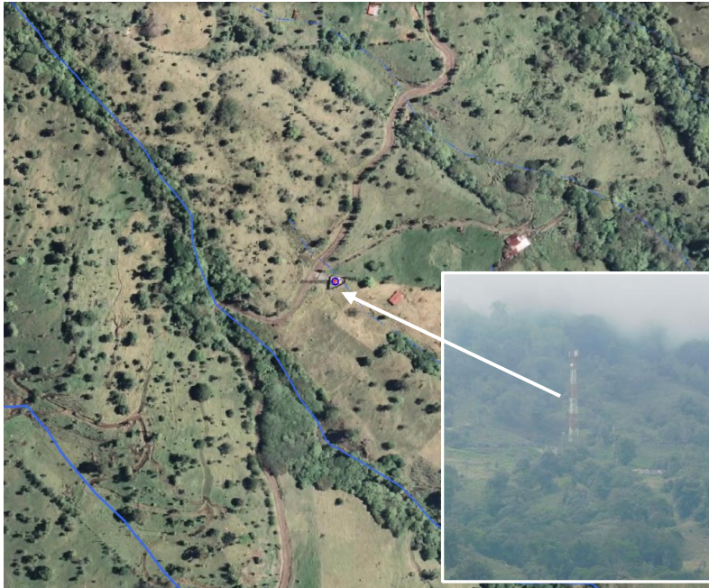
Imagen 18. Imagen de la torre en la Reserva Forestal Cordillera Volcánica Central, en la imagen se ve que la cobertura vegetal en el entorno en que se ubica esta torre es de pastos con árboles dispersos, con presencia de parches de bosque de ribera asociado al drenaje de la zona.
