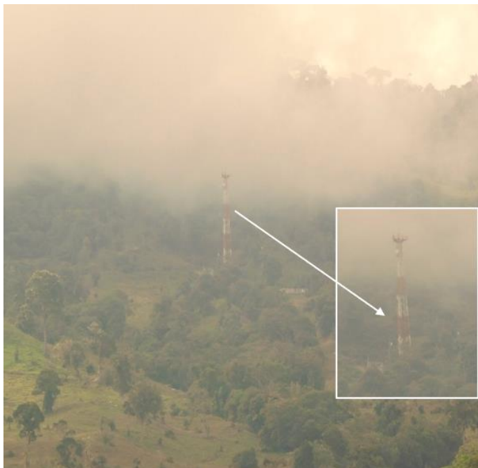
Imagen 04. En la imagen se puede observar una torre de telecomunicación en el macizo del Volcán Turrialba, vista desde el poblado de Torito, en la imagen se puede observar que, si bien la estructura se ubica en terrenos con pendientes fuertes, también se ve la cobertura natural en los terrenos cercanos lo cual brinda soporte y disminuye con esto los problemas que se puedan tener con la inestabilidad de los terrenos en estos sectores.
