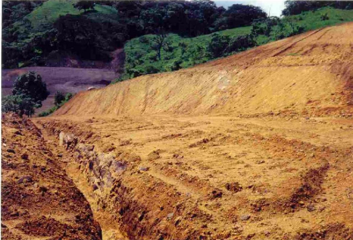
*Nuevamente, se observan las características arcillosas de los suelos del sector. Aquí, se trata de la preparación de un lote al construir terrazas. En la trinchera que se observa a la izquierda, se enterrarán los cables y se construirán las cañerías.*
