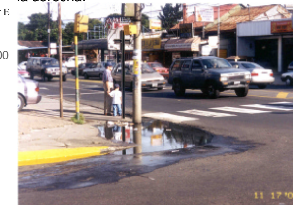
Foto 5. Acera con problemas de inundación cerca de un paso peatonal.
