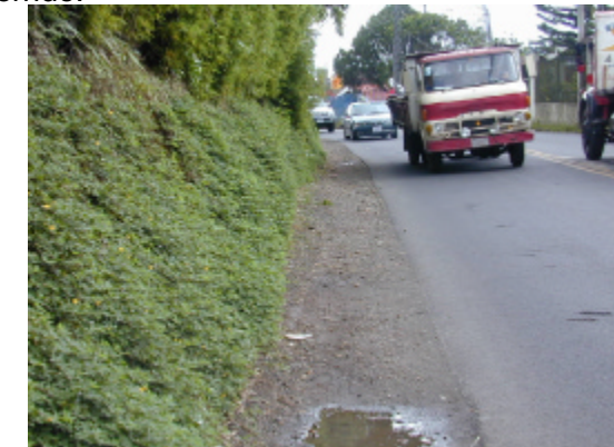
Foto 10. La ausencia de aceras en sitios donde el flujo vehicular es frecuente, pone en riesgo a los peatones.
