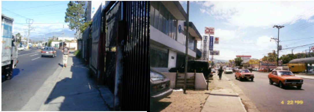
Fotografía 18. Acera en la que el peatón esta obligado a caminar cerca del paso de los vehículos. Mercedes, Montes de Oca.
