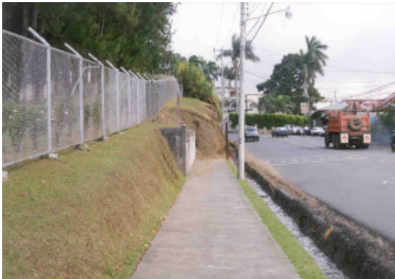
Fotografía 12. Segmento de acera en buenas condiciones ubicado frente al colegio Metodista. Al no presentar continuidad, el usuario debe cruzar la calle. Sabanilla, Montes de oca.
