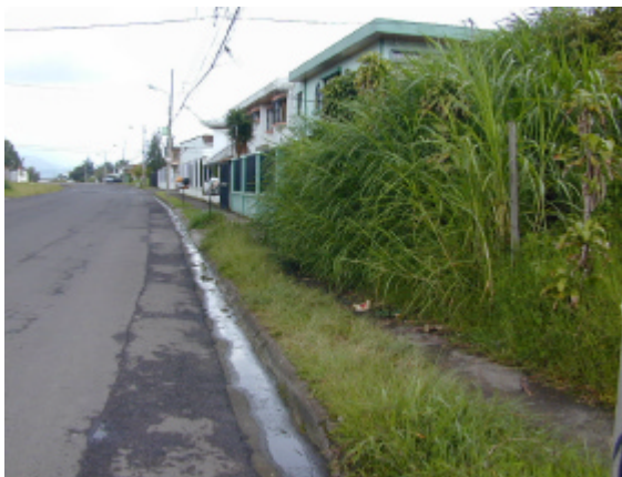
Fotografía 10. Mal mantenimiento de aceras. San Pedro, Montes de Oca.
