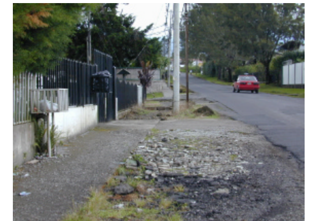
Foto 15. Las aceras cuya superficie se encuentra en mal estado, no son utilizadas por los peatones.
