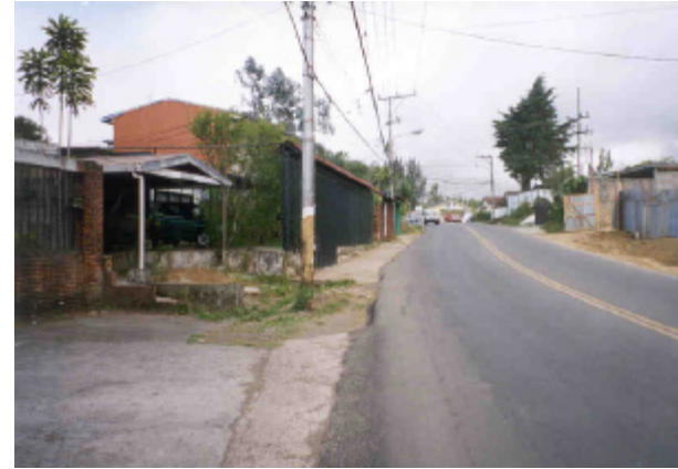
Foto 7. La ubicación de postes como se muestra en la figura, provoca una reducción del ancho de la acera, obligando a los peatones a pasar cerca de los vehículos.
