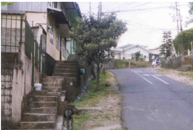
Fotografía 8. Acera poco utilizada por un diseño inadecuado de este tramo. Calle al Chorro, Sabanilla, Montes de Oca.
