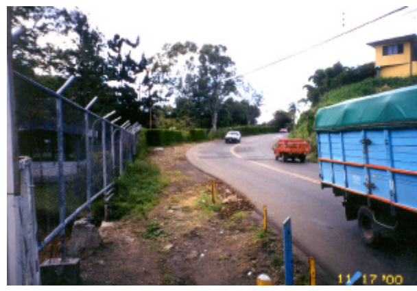
Foto 2. Tramo de carretera en la que no existe acera.
