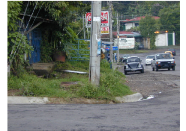
Foto 14. Tramo de carretera sin acera.
