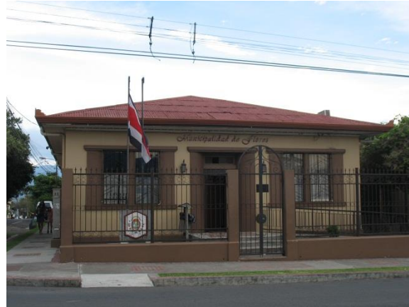
Fotografía 6-2.28 Edificio Municipal de Flores. Fuente: Trabajo de campo, ProDUS, 2012
