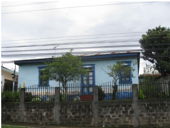
Fotografía 6-2.5 Casa de adobes, San Lorenzo. Fuente: Trabajo de campo, ProDUS, 2012
