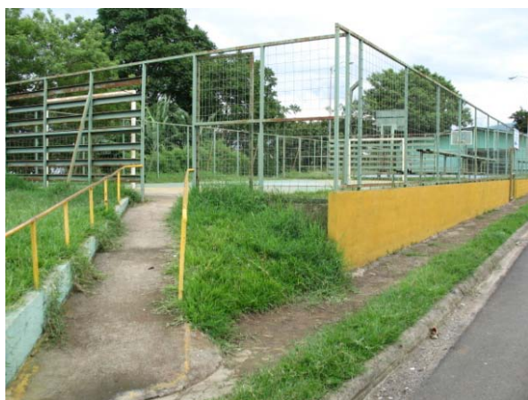
Fotografía 9.3.9 Rampa de acceso y baranda que facilita el ingreso en Cancha de Las Flores. Fuente: trabajo de campo ProDUS, 2012
