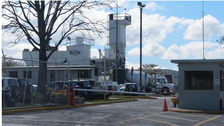
Fotografía 8.2.7 Fachada de la Concretera América Concretos S.A. (AMCO) Fuente: ProDUS-UCR (Febrero 2013).
