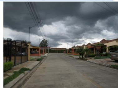
Fotografía 9.2.16 Calle de concreto en buen estado, Residencial El Campanario. Fuente: Trabajo de campo, ProDUS, 2012
