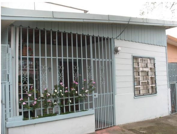
Fotografía 6-2.13 Casa de madera con zócalo de concreto, San Joaquín centro. Fuente: Trabajo de campo, ProDUS, 2012
