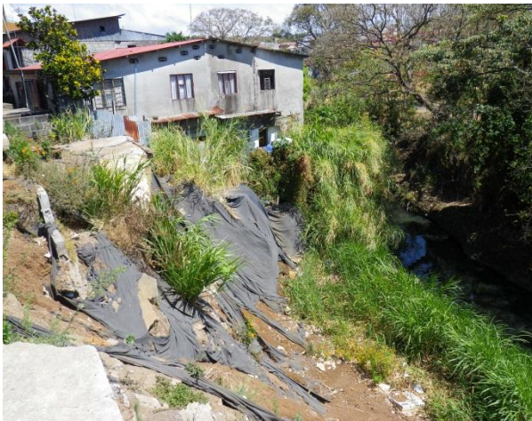
Fotografía 3.1-1 Deslizamientos de terreno en margen de la Quebrada Seca. Flores, enero 2013.
