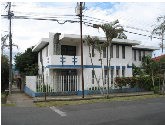
Fotografía 6-2.25 Casa de influencia de arquitectura moderna, San Joaquín. Fuente: Trabajo de campo, ProDUS, 2012
