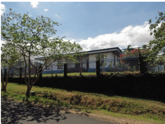
Fotografía 6-2.5 Casa de adobes, Llorente centro. Fuente: Trabajo de campo, ProDUS, 2012
