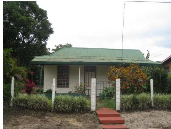
Fotografía 6-2.18 Casa de madera con corredor frontal. Fuente: Trabajo de campo, ProDUS, 2012
