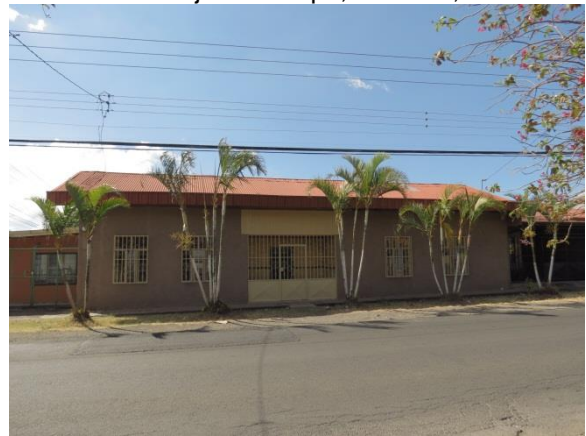
Fotografía 6-2.4 Casa de adobes, Llorente. Fuente: Trabajo de campo, ProDUS, 2012
