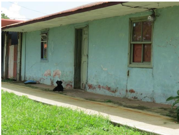
Fotografía 6-2.7 Casa de adobes. Fuente: Trabajo de campo, ProDUS, 2012
