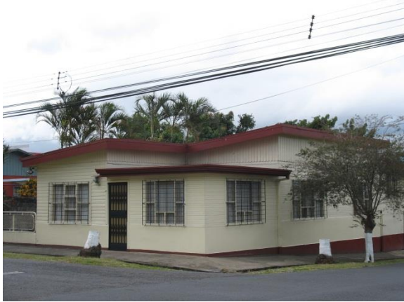
Fotografía 6-2.15 Casa de madera con concreto en la base, San Joaquín centro. Fuente: Trabajo de campo, ProDUS, 2012
