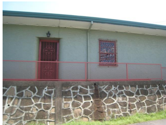
Fotografía 6-2.8 Casa de adobes. Fuente: Trabajo de campo, ProDUS, 2012
