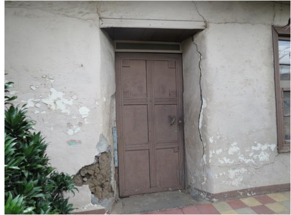
Fotografía 6-2.10 Detalle de la entrada principal de una casa de adobe en San Joaquín-Llorente. Fuente: Trabajo de campo, ProDUS, 2012
