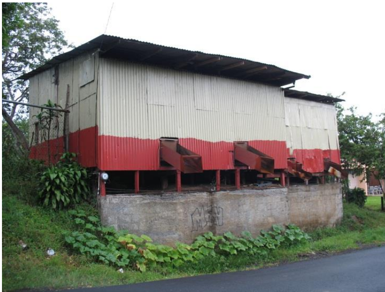
Fotografía 6-2.4 Recibidor de café. Construido en madera, cubierta y forro de hierro galvanizado. Su arquitectura es de carácter primordialmente utilitario, este tipo de edificación es frecuente encontrarla en el paisaje del Valle Central. Es testigo material de la relevancia que tuvo en un pasado la actividad cafetalera en Flores.
