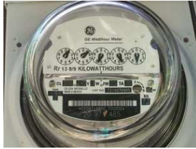
Contador de electricidad 90.28
