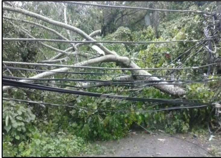
Figura 60. Árbol caído en la localidad de Corralar en Tabarcia de Mora a causa de los fuertes vientos, interfiriendo con el tendido eléctrico como con la obstrucción de caminos. Fuente: Diario Extra 2016
