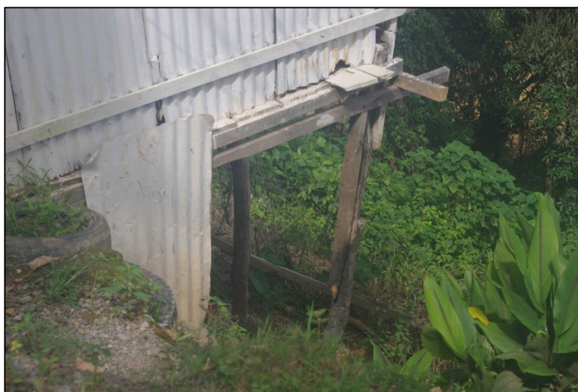
Figura 28. Soportes de madera sosteniendo unidad habitacional hecha con tejas de polialumino en una zona de fuertes pendientes.
