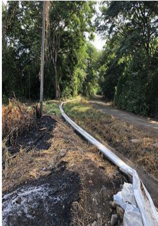
A 29. Conducción de poliducto polypipe
