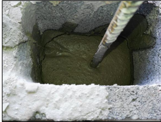
Figura 39. Llenado de celdas con acero vertical.
