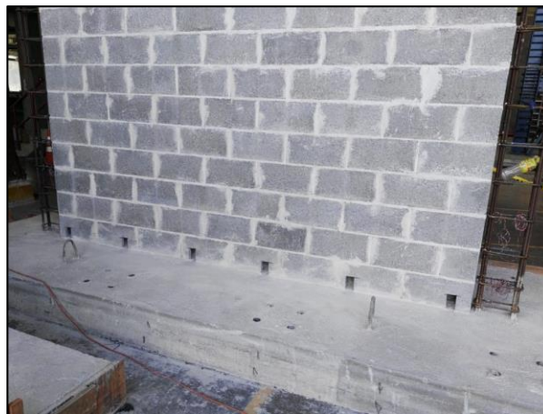
Figura 36. Ventanas de inspección para el colado de altura.
