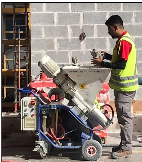
Figura 37. Equipo Monomix para el colado del concreto de relleno.
