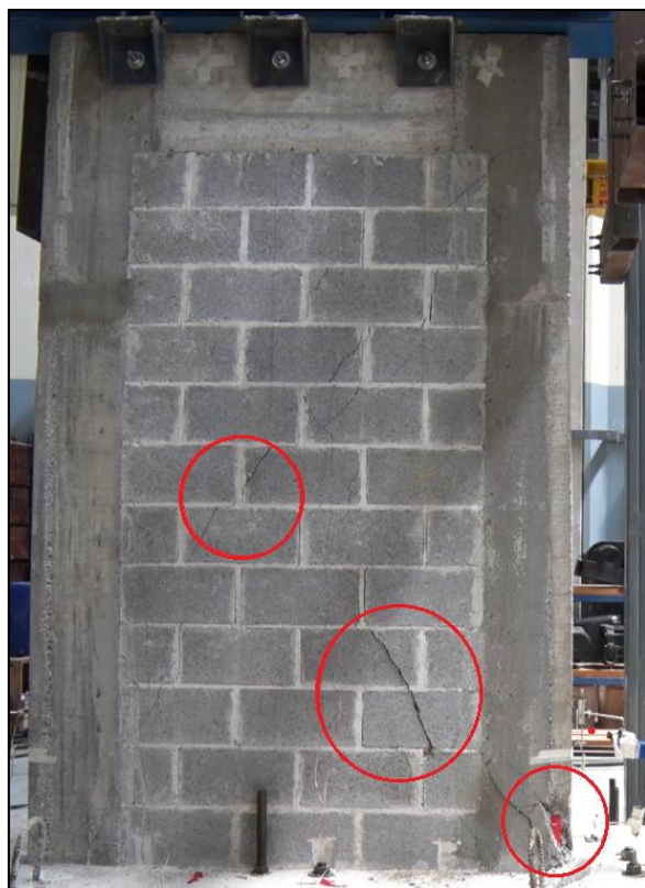
Figura 61. Agrietamiento Muro RA1.5 para el desplazamiento \pm 51 mm.
