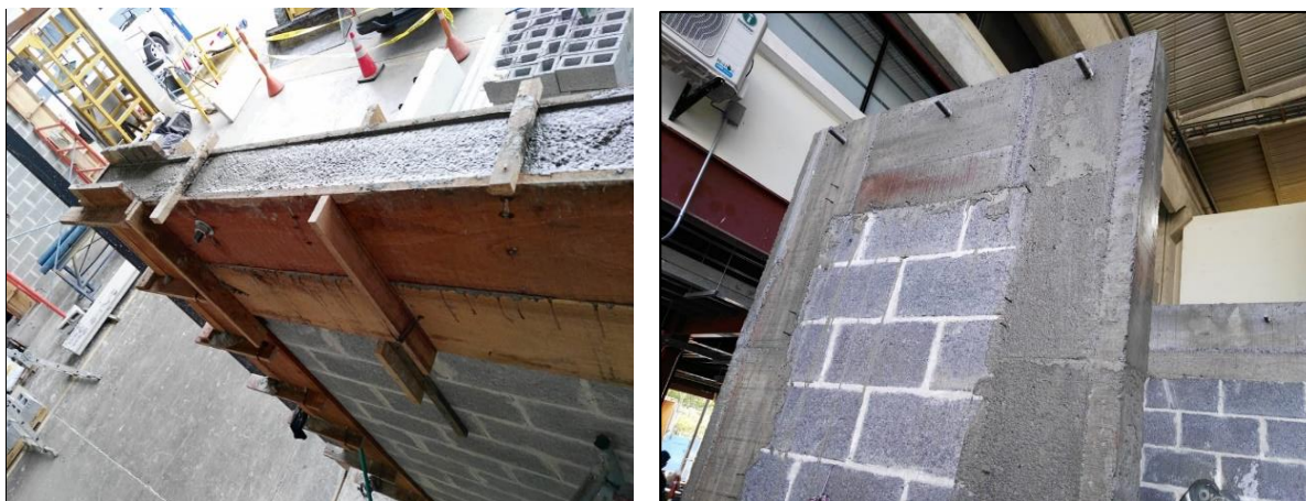
Figura 41. Vigas y columnas coladas.
