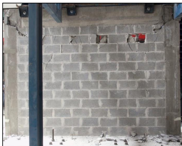
Figura 53. Estado final del Muro RA.75.
