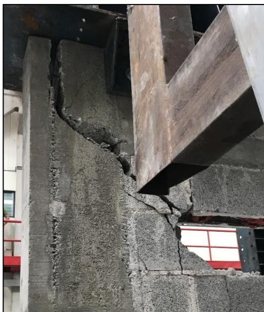
Figura 59. Estado final del nudo RA1.
