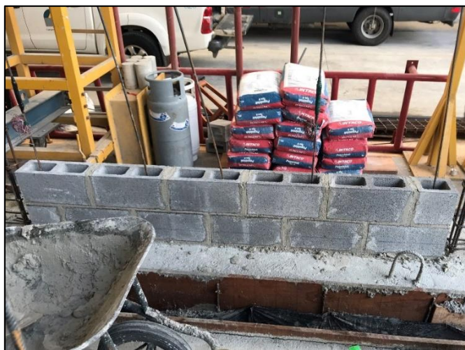
Figura 34. Primeras hiladas de bloques colocadas.
