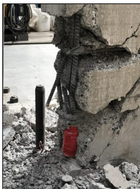
Figura 67. Estado final de base de la columna en Muro RA2.
