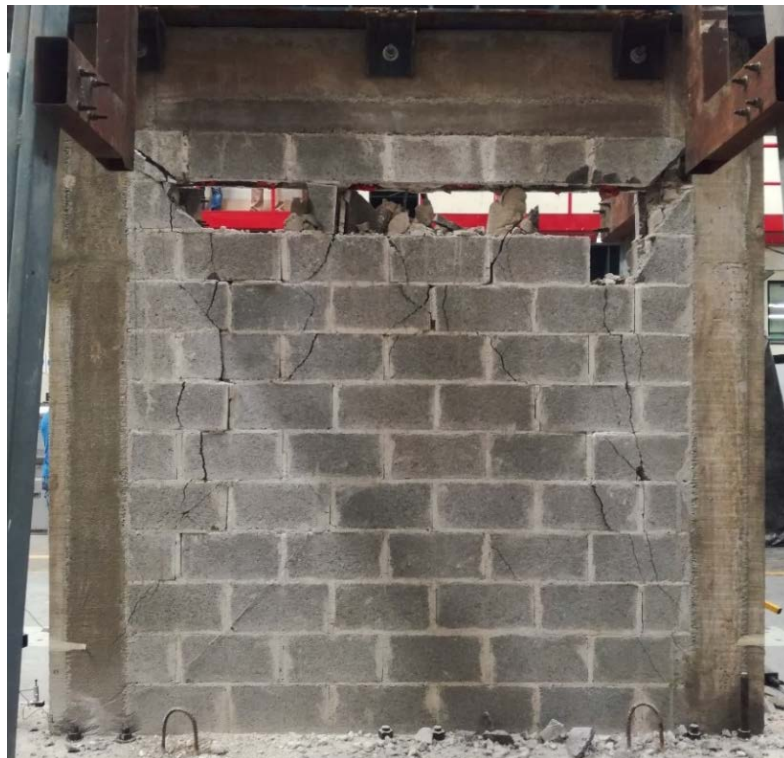
Figura 65. Condición final del Muro C.
