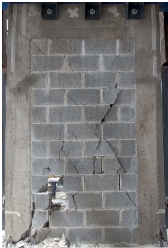
Figura 70. Condición final del Muro D.
