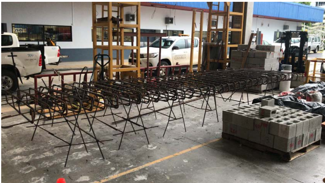
Figura 31. Armadura de la cimentación para el Muro A.
