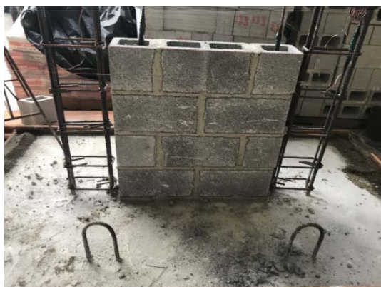
Figura 36. Construcción de las primeras 4 hiladas del Muro E.
