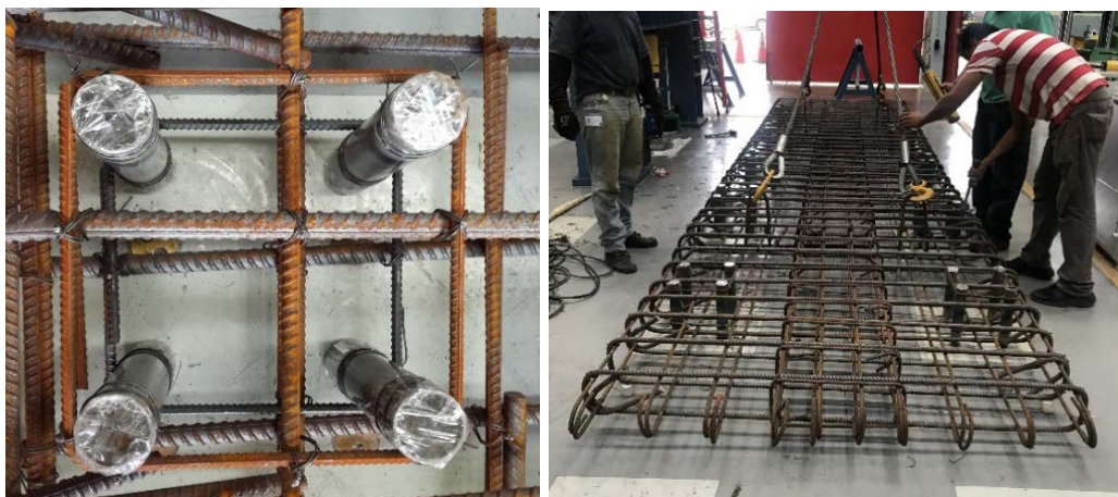
Figura 32. Ductos de pernos y ajuste en el piso fuerte.
