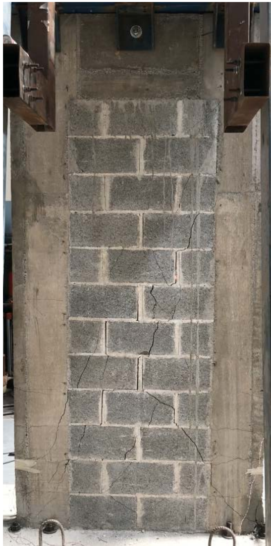
Figura 73. Agrietamiento parcial en el Muro E para el 1° ciclo de la 10° serie ( \pm 90 mm).
