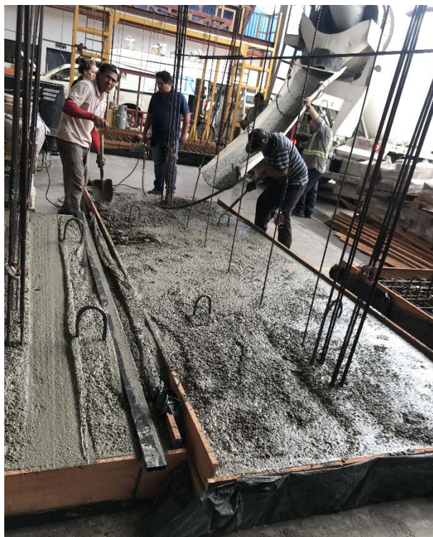
Figura 35. Colado de las cimentaciones con concreto premezclado.
