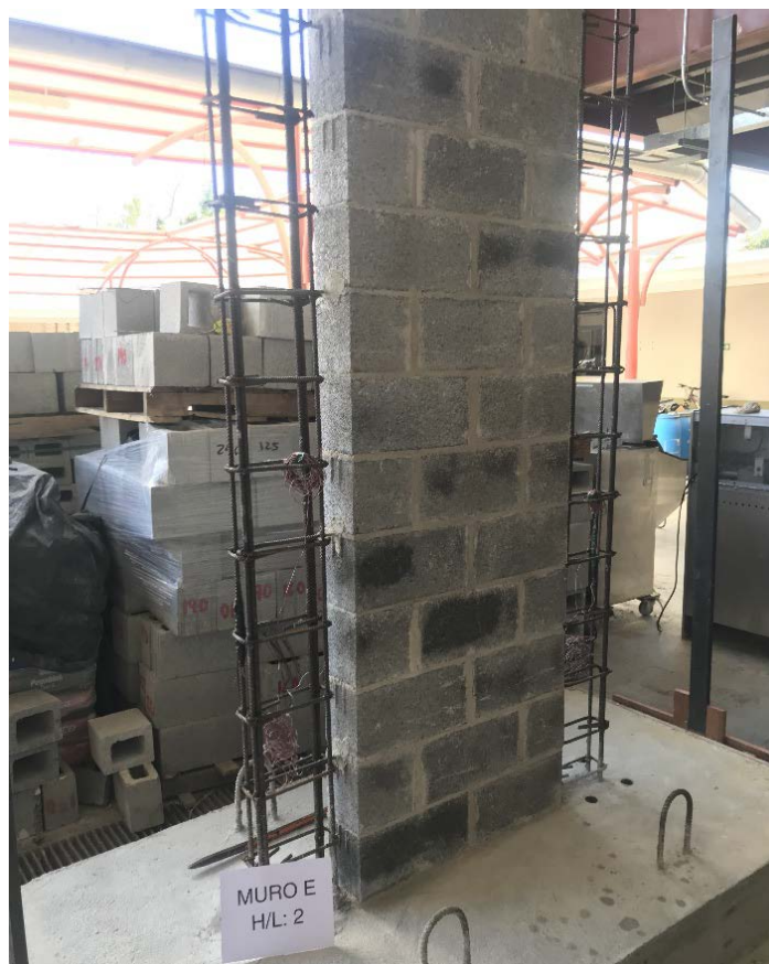
Figura 37. Paño terminado del Muro E.
