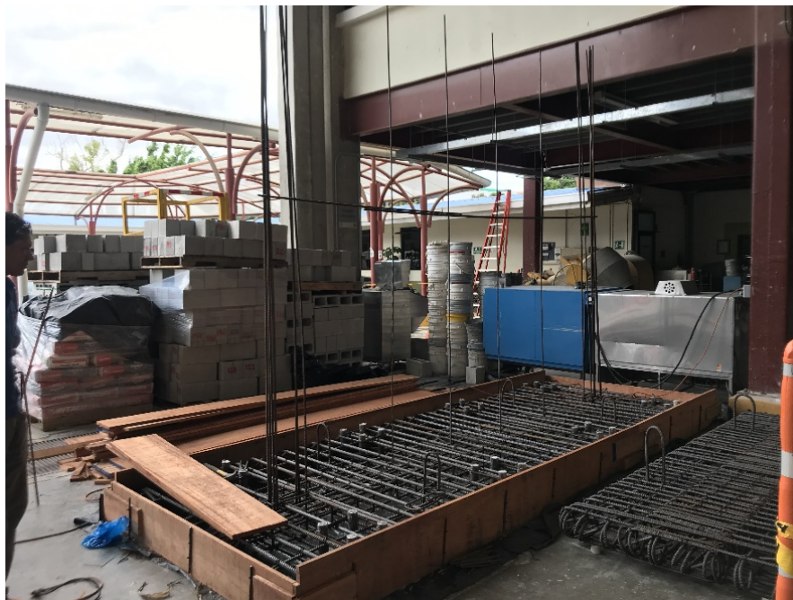
Figura 33. Cimentación encofrada con acero vertical colocado.
