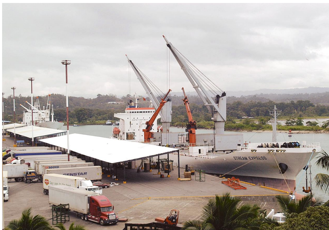
Las vías municipales en buen estado contribuirían con la actividad portuaria, motor del desarrollo de Limón.
