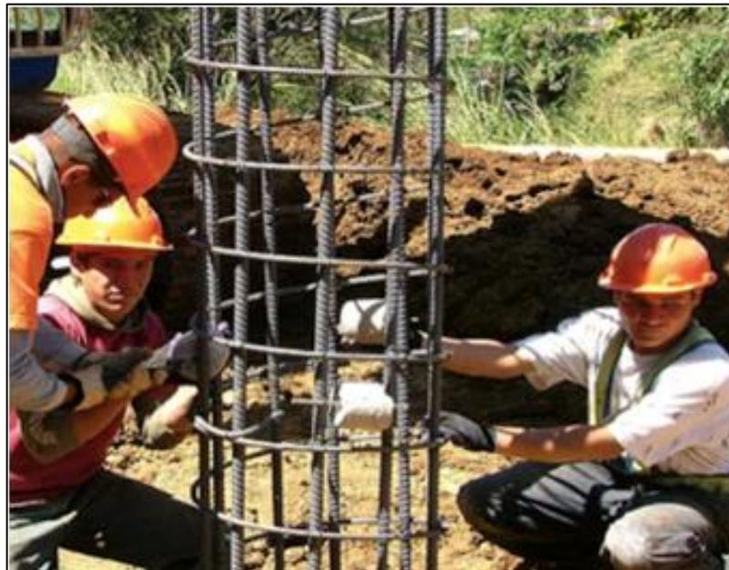
*Figura 136. Esquema de colocación de la armadura en un pilote preexcavado.*
