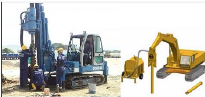
*Figura 137. Esquema de la maquinaria utilizada en la construcción de un pilote preexcavado.*
