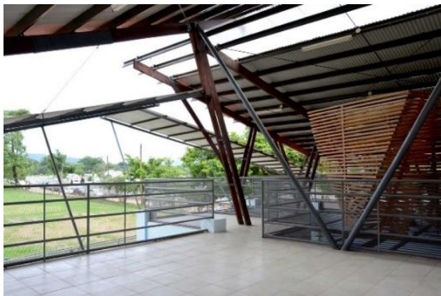
Ilustración 32: Vista interna del proyecto. Fuente: Centro de Cuido y Desarrollo Infantil de Nicoya, Entre Nos Atelier, 2013, ( http://arquitecturaenacero.org )
