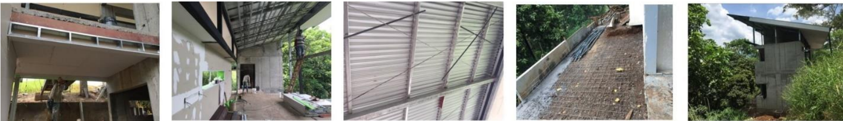
Ilustración 69: Construcción de cubierta de techo y balcón. Fuente: AE Diseño y Arquitectura, 2019.
