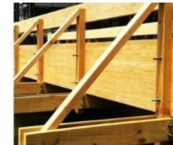
Puente de acceso de madera.
