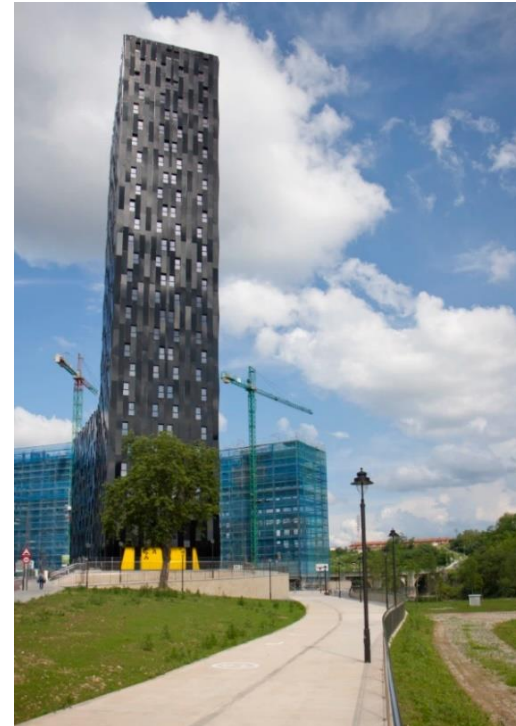
Ilustración 11: Foto del proyecto durante su construcción. Fuente: bilbaoenconstruccion.com, 2020.
