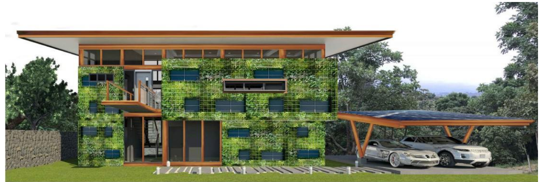
Paneles ubicados sobre la cubierta de los parqueos.
