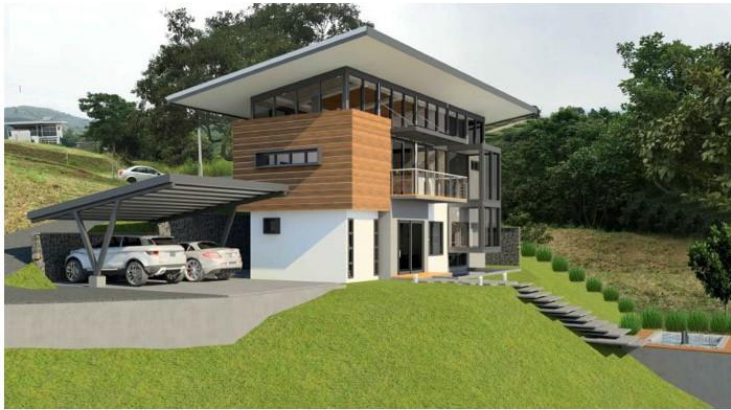
:: Vistas perspectiva Noreste antes de la intervención
