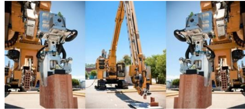
Ilustración 52: HADRIAN robot albañil. Fuente: planoyescala.com, 2020.
