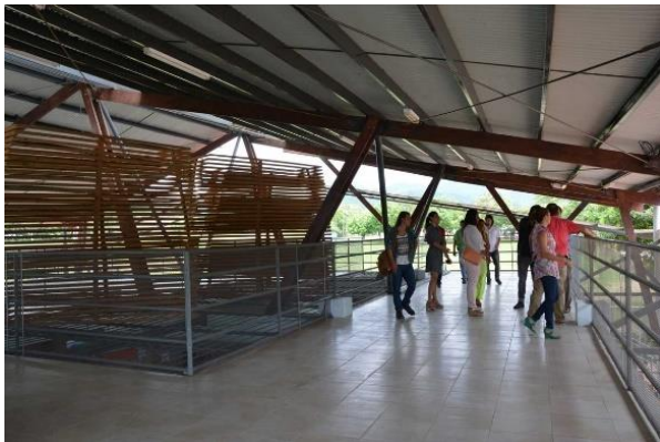
Ilustración 34: Vista interna del uso de tensores en el proyecto.
