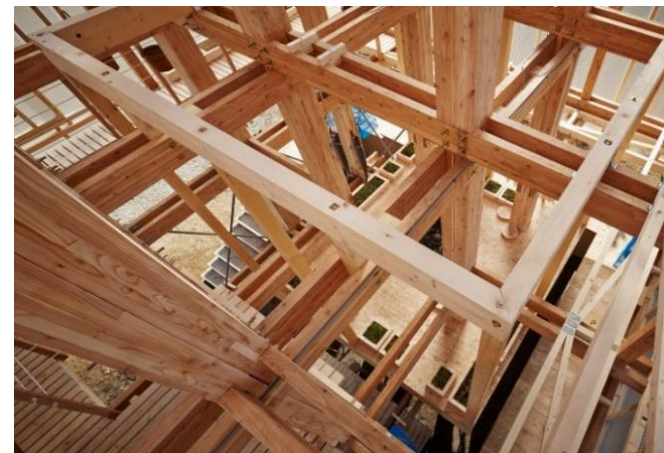
Ilustración 15: Marco estructural de madera del proyecto. Fuente: Nest We Grow / Kengo Kuma & Associates + College of Environmental Design UC Berkeley, 2014, ( https://archdaily.com )
