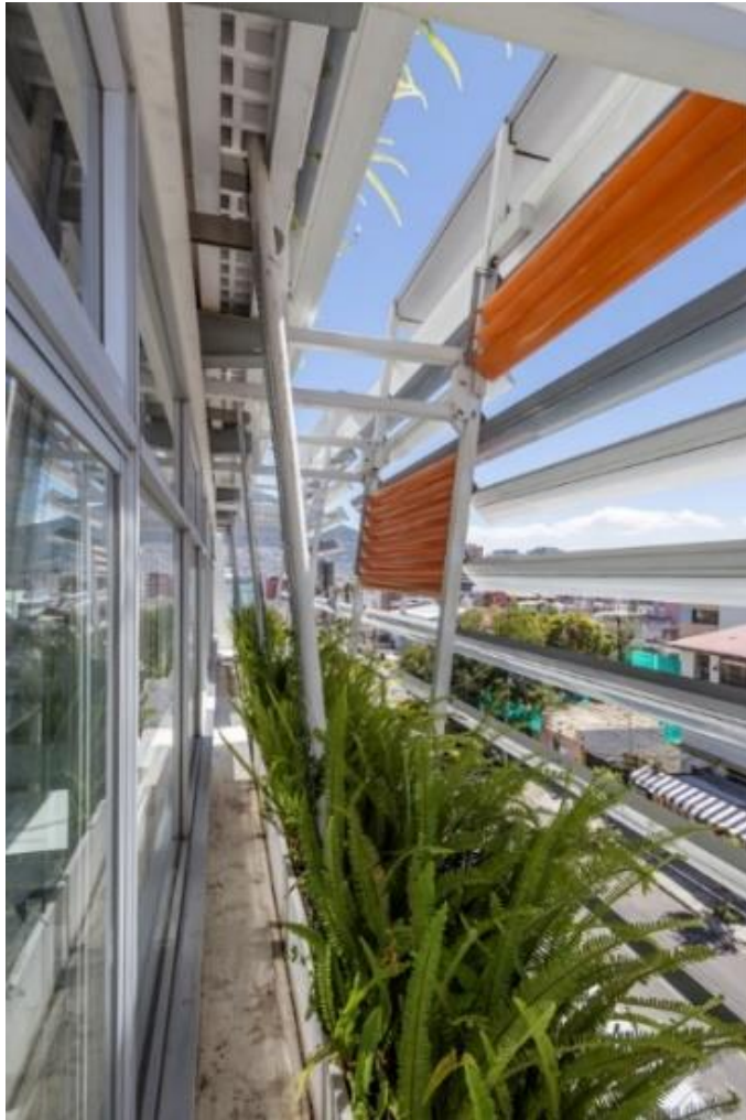
Ilustración 28: Componentes de la fachada. Fuente: Quito Publishing House. Estudio A0, Quito, 2014 ( https://archdaily.com )
