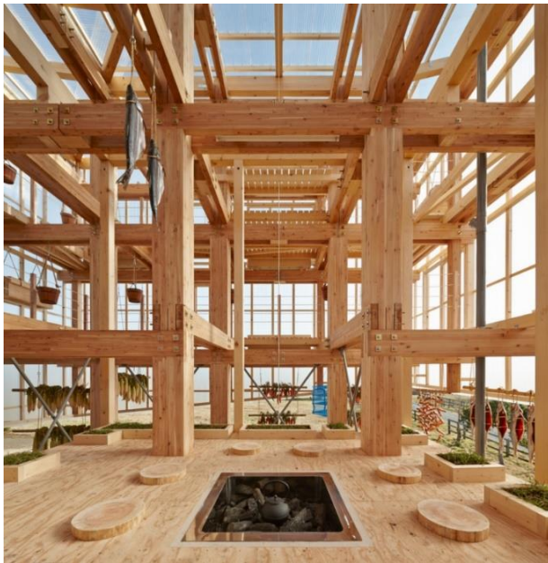
Ilustración 13: Vista interna de la estructura.
