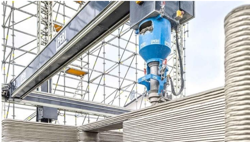
Ilustración 46: Impresora 3D de concreto. Fuente: el español.com, 2020.
