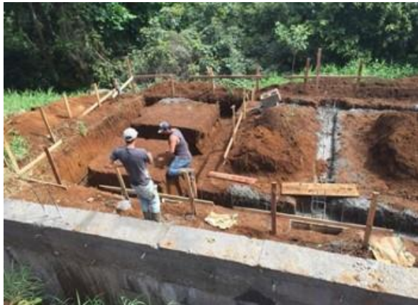
Ilustración 63: Construcción de los cimientos. Fuente: AE Diseño y Arquitectura, 2019.
