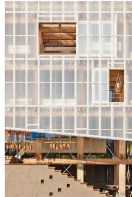
Ilustración 17: Uso de láminas de plástico en la fachada. Fuente: Nest We Grow / Kengo Kuma & Associates + College of Environmental Design UC Berkeley, 2014, ( https://archdaily.com )
