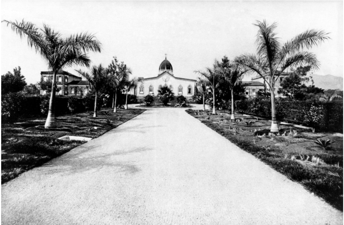
Imagen N° 31 Exteriores del Asilo Chapuí: Fachada Fuente: Archivo Nacional, c.a. 1909. Foto: s.a.
