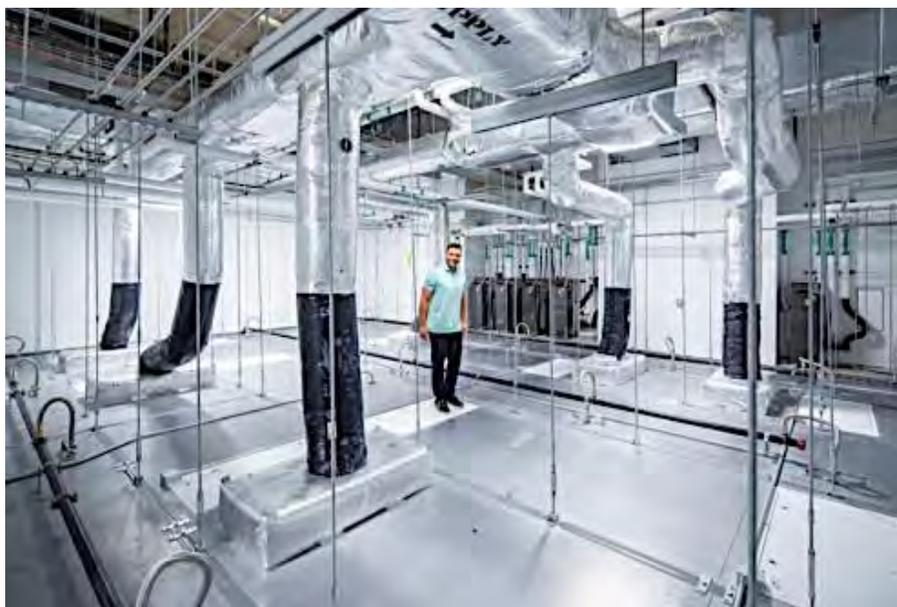
Ilustración 8. Cielo caminable. Fuente: <https://www.aesclean.com/cleanroom-components/aes-modular-wall-ceiling/>, 2020
