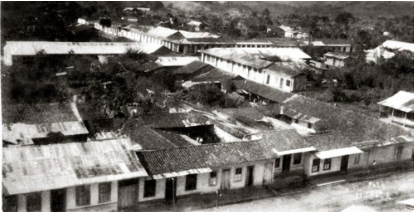
Figura 10. Costado oeste de la Parroquia de San Ramón, fotografía posterior a 1924
