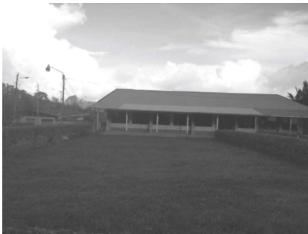
Salón de la iglesia de San Antonio en la actualidad, es aquí donde se realizan las fiestas patronales. Con el paso del tiempo ha experimentado varias remodelaciones, pero su estructura es básicamente la misma desde que se construyó.
