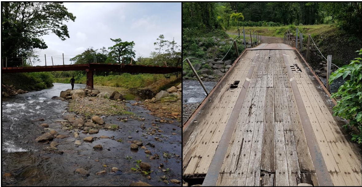
Puente 2 sobre el río Bijagua
