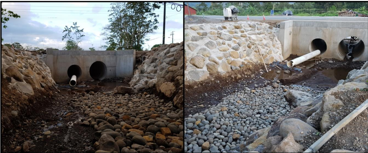
Alcantarilla en la quebrada intermitente en Bijagua
