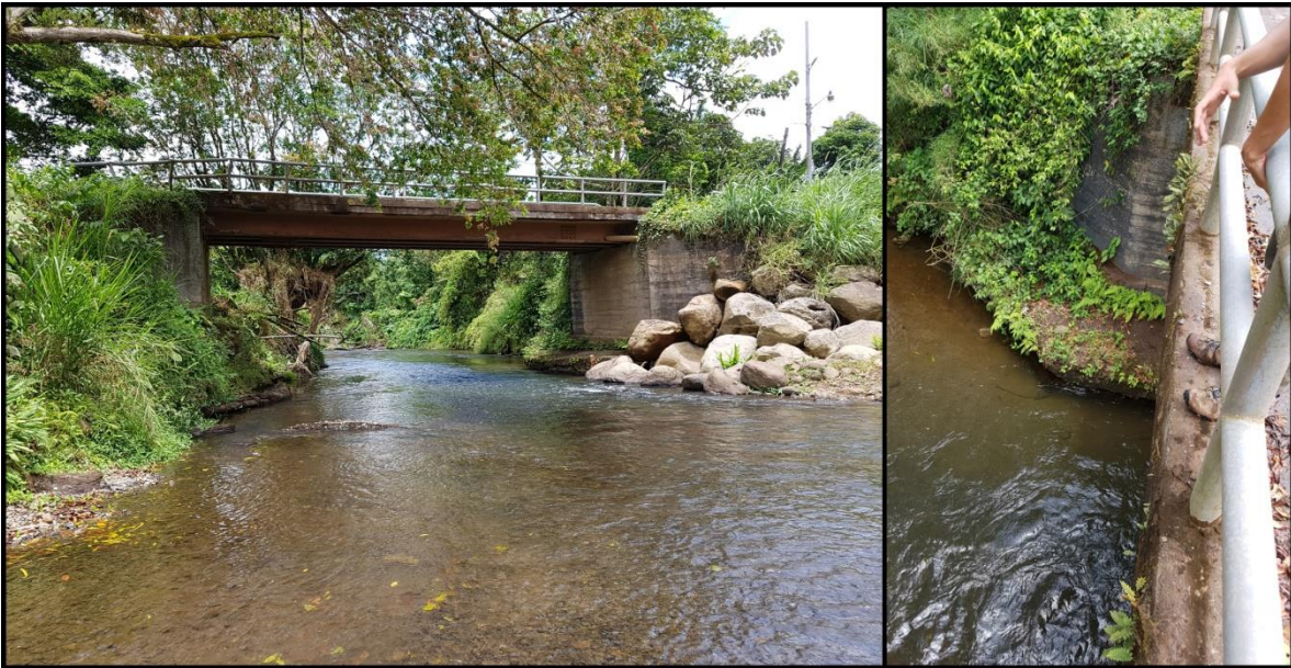
Puente 3 sobre el río Bijagua
