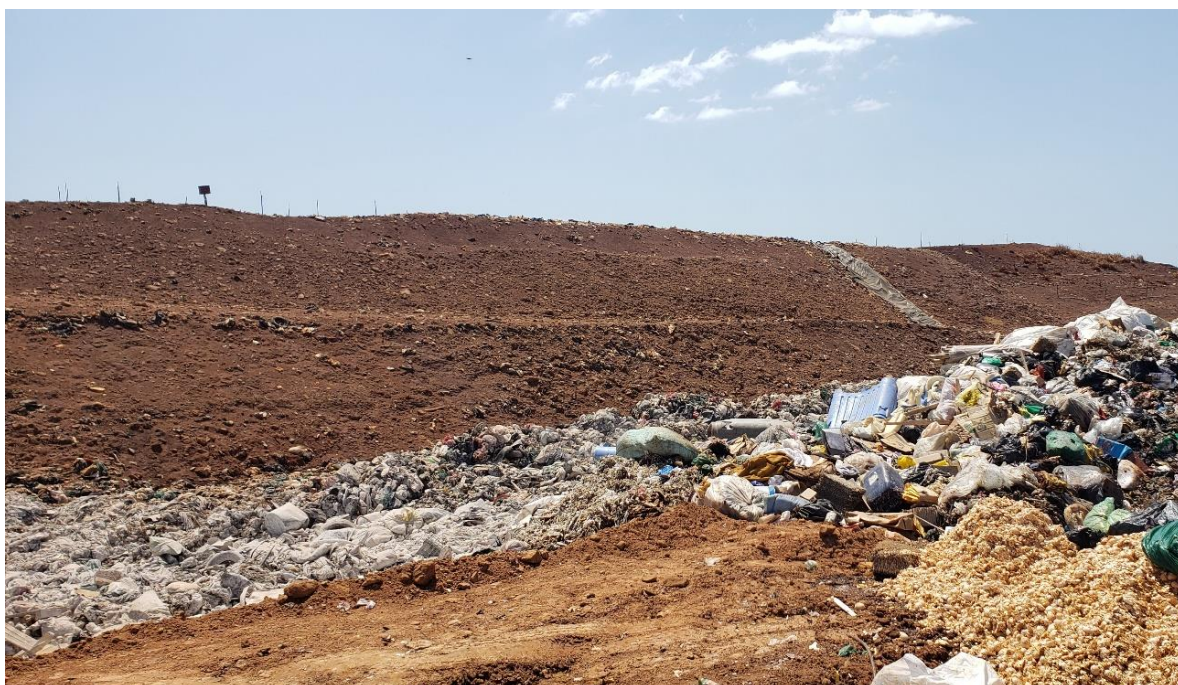
Figura 14. Uso de terrazas para la construcción de celdas.
