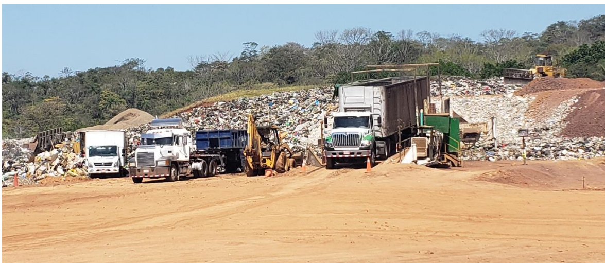
Figura 71. Operación del relleno mediante el uso de maquinaria
