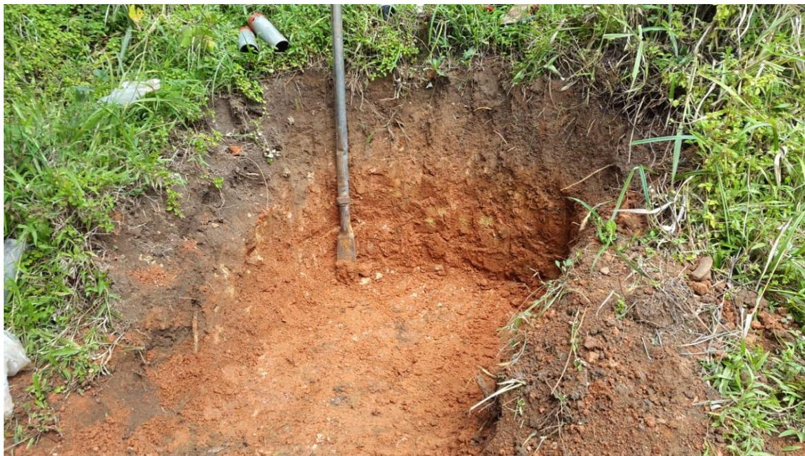
*Figura 1.13. Excavación de calicata de investigación*
