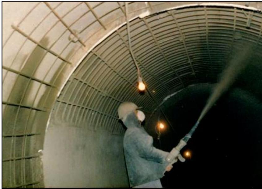
*Figura 3.14. Operario aplicando concreto lanzado en el interior de un túnel*
