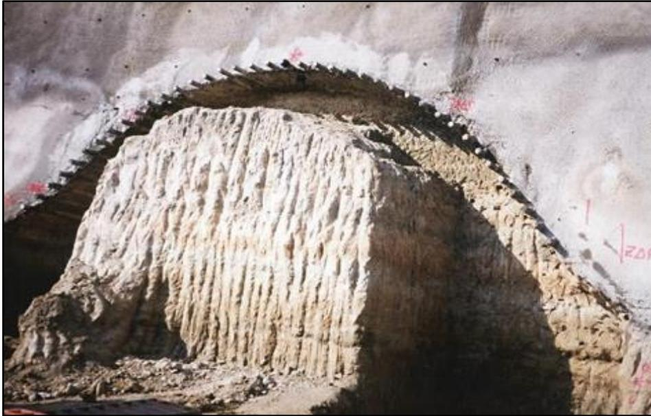
*Figura 3.17. Colocación de sostenimiento mediante pantalla de micropilotes*
