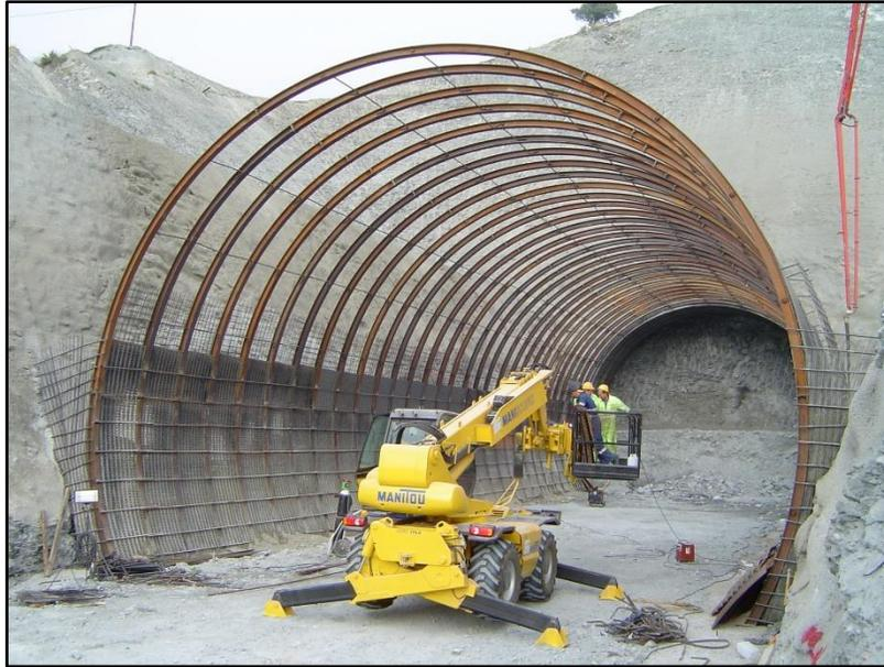
*Figura 3.18. Cuadros metálicos en forma de herradura para construcción de túnel falso*
