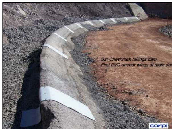
Figura 4.45. Proceso de instalación de geomembrana Carpi – instalación de bandas de anclaje
