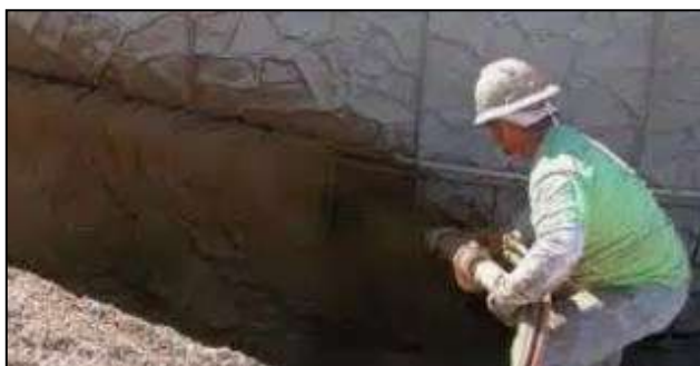
Figura 2.43. Concreto lanzado con pigmento color café
