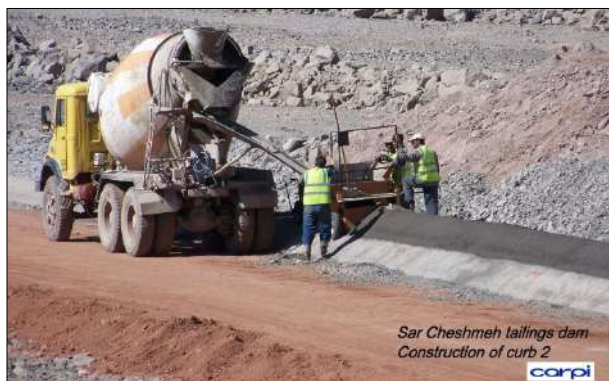
Figura 4.44. Proceso de instalación de geomembrana Carpi - construcción del bordillo
