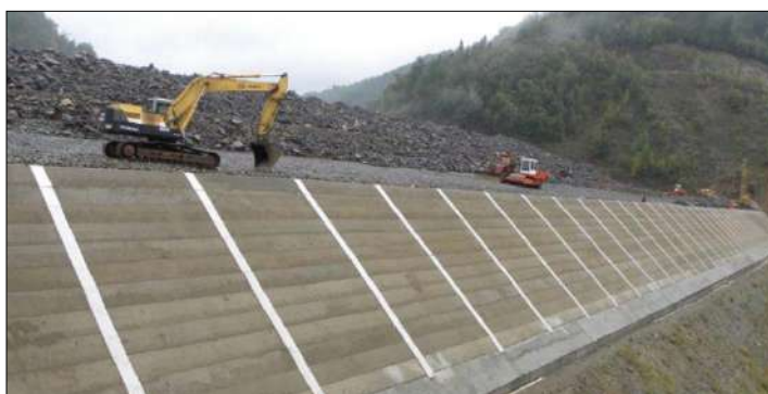
Figura 4.47. Instalación de bandas de anclaje de geomembrana Carpi
