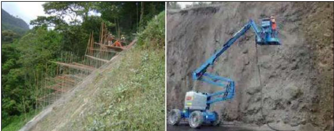
Figura 2.39. Sistemas provisionales de sostenimiento del equipo
