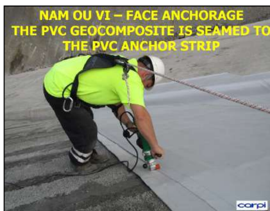
Figura 4.50. Soldadura térmica – instalación geomembrana Carpi
