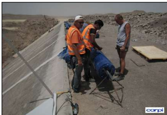
Figura 4.48. Rollos de geomembrana Carpi en el sitio
