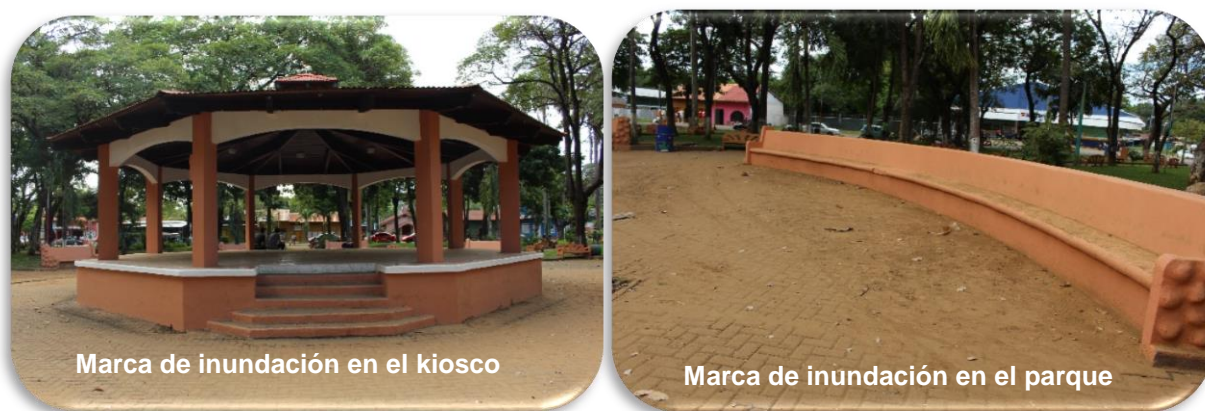
Figura 49: nivel del agua producto de la inundación, marcado en el parque central de Sardinal. Fotos: Mario Arias
