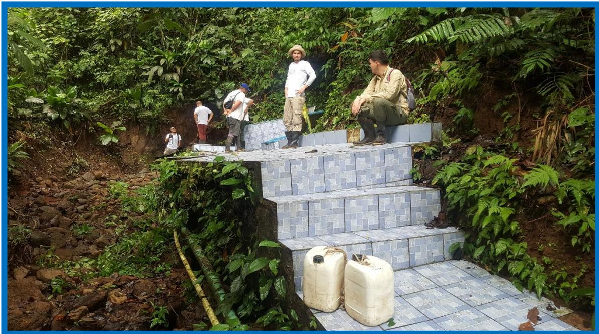
**Fotografía que muestra la afectación en la estructura de captación de uno de los manantiales de la ASADA Patate, producto del movimiento del suelo. Foto: Ricardo Pastrana, 2018.**
