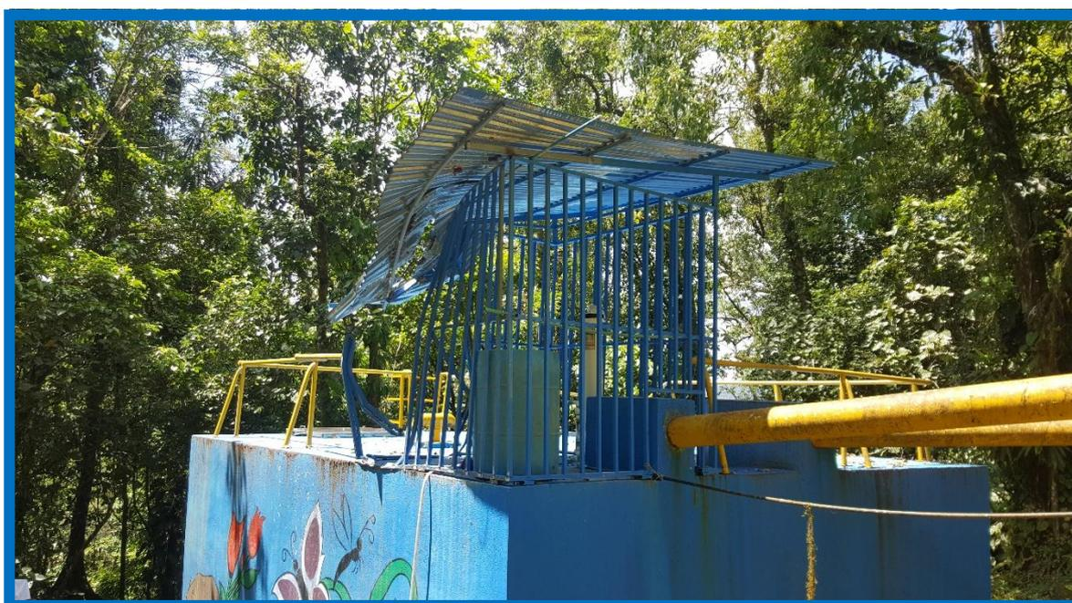
**Afectación al techo de la estructura que resguarda al clorador de una naciente en Bijagua, producto de la caída de un árbol por efecto de las ráfagas de viento generadas por la Onda Tropical Nate. Foto: Mario Arias, 2018.**
