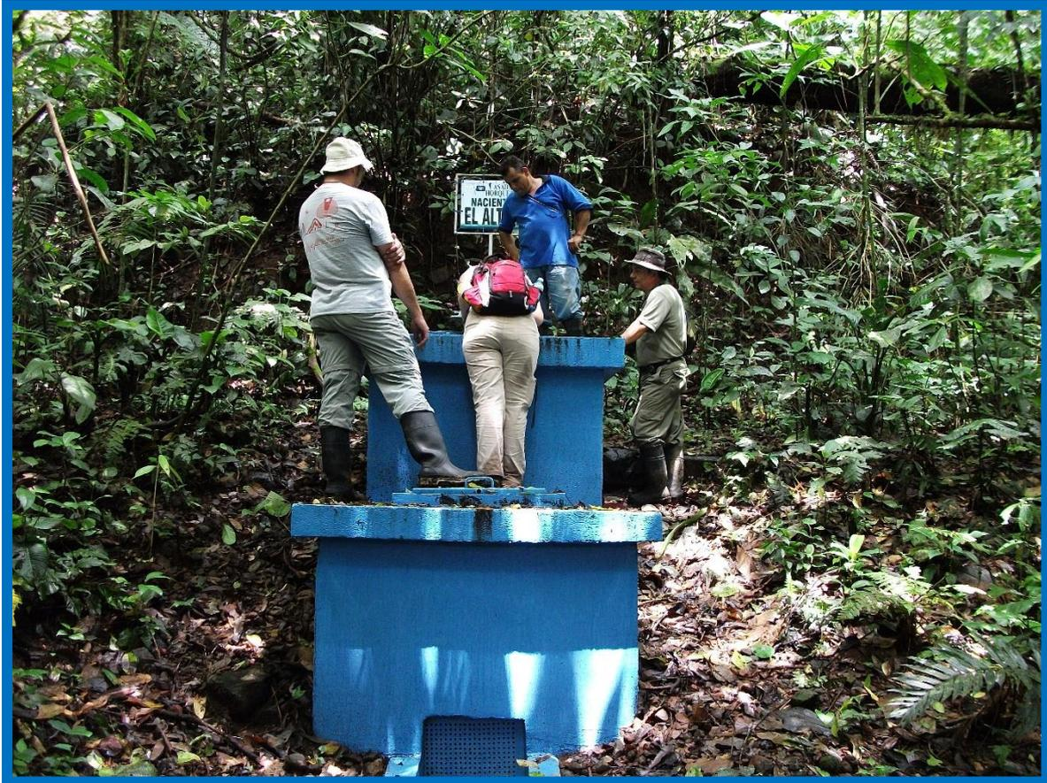
**Fotografía de un manantial de ladera concentrado, en la cual se aprecia la estructura de captación. Manantial El Altar, Sarapiquí. Foto Mario Arias, 2012.**
