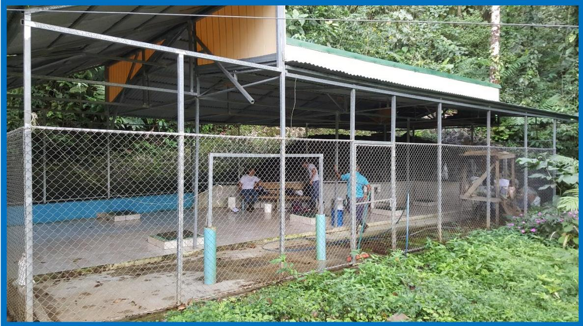
**Fotografía de la captación del Manantial Santa Fe, Guatuso. Obsérvese la malla perimetral de protección, el enchape en cerámica de la captación e incluso se encuentra techada.
