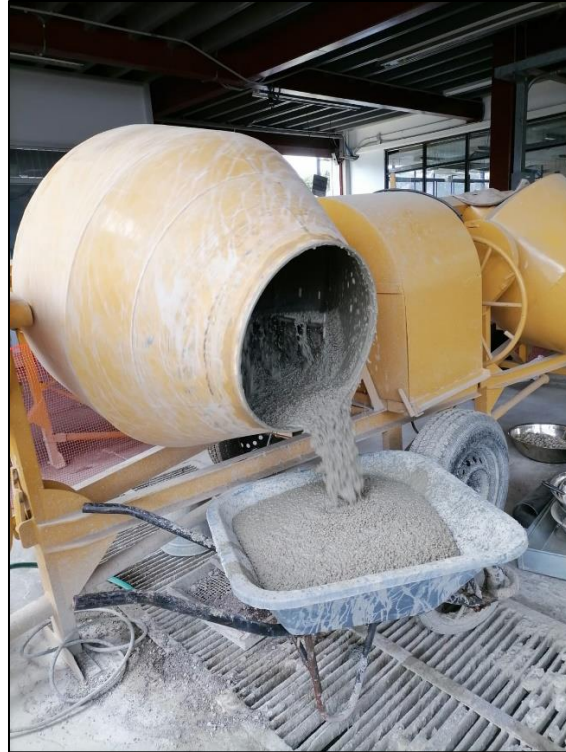
Figura 3-4. Fabricación del concreto de relleno.
