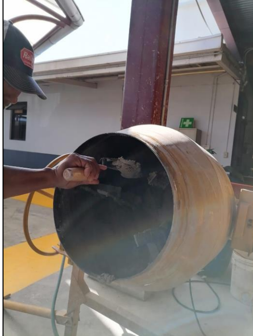
Figura 3-2. Elaboración del mortero de pega.
