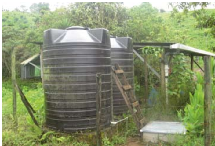
Tanques plásticos de almacenaje de agua llovida, capacidad de 5000 litros. Turrialba, Costa Rica, 2009
