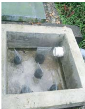
Ejemplo de filtros en tanques de almacenamiento de agua llovida y tanques de almacenamiento, Turrialba, Costa Rica, 2009.
