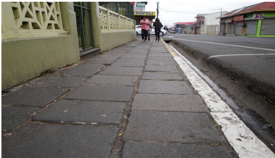
Fotografía 4. Acera histórica empedrada o de “baldosas de granito” junto al desnivel de una calle recién asfaltada en el centro de la ciudad de Cartago. Fuente: Núñez, 2018
