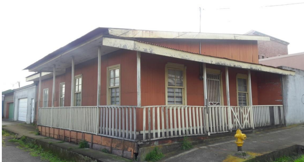
Fotografía 19. Casa criolla, ubicada en Barrio Los Ángeles, construida en la primera mitad del siglo XX. Fuente: Núñez, 2018
