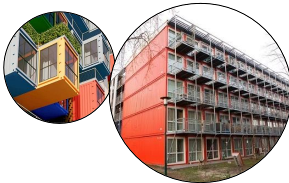
Imagen No. 60. Diseños residenciales con contenedores
