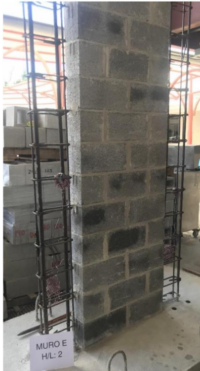
Imagen 28. Muro construido de mampostería confinada reforzada.
