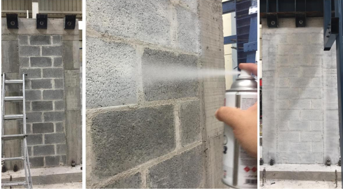
Imagen 53. Limpieza del muro y aplicación de la pintura base color blanco.
