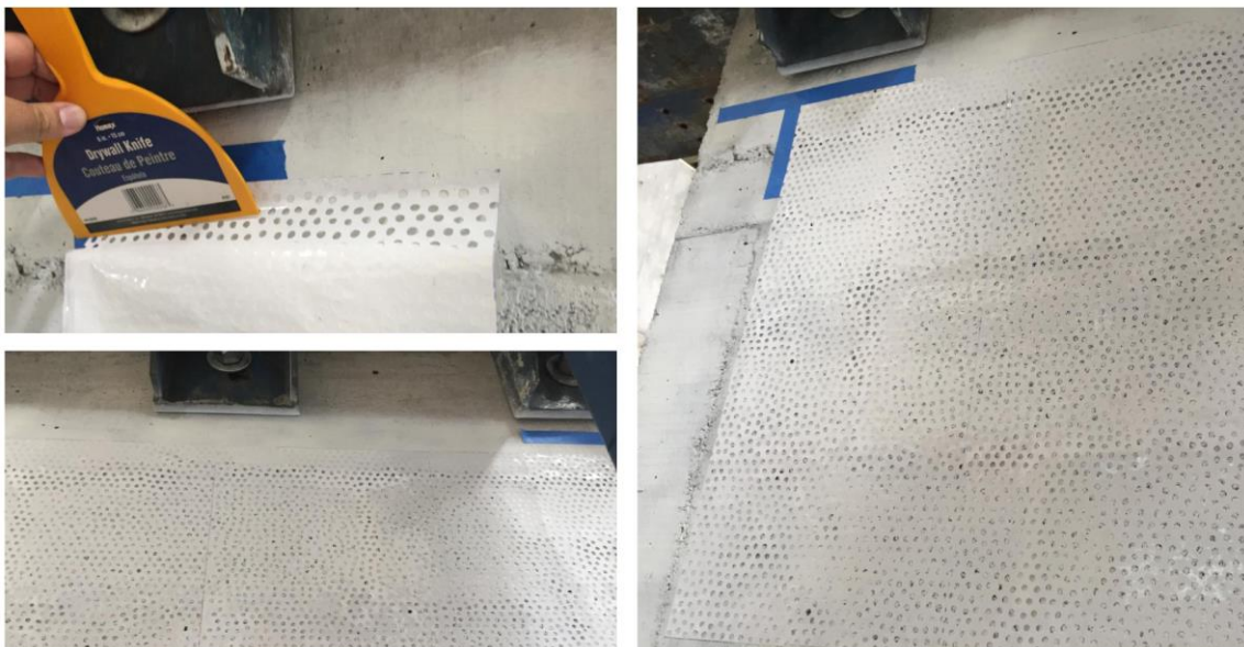
Imagen 54. Colocación de la plantilla o stencil en secciones a la superficie del muro.
