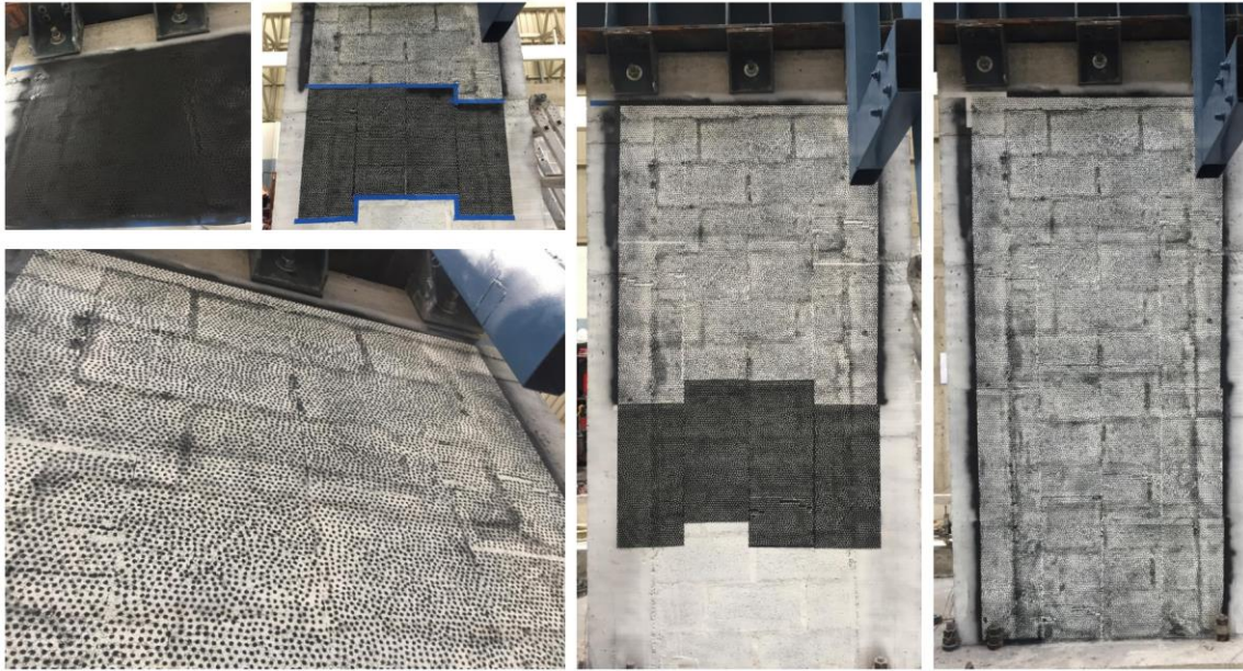
Imagen 55. Aplicación de pintura de color negro y acabado del patrón de manchas.
