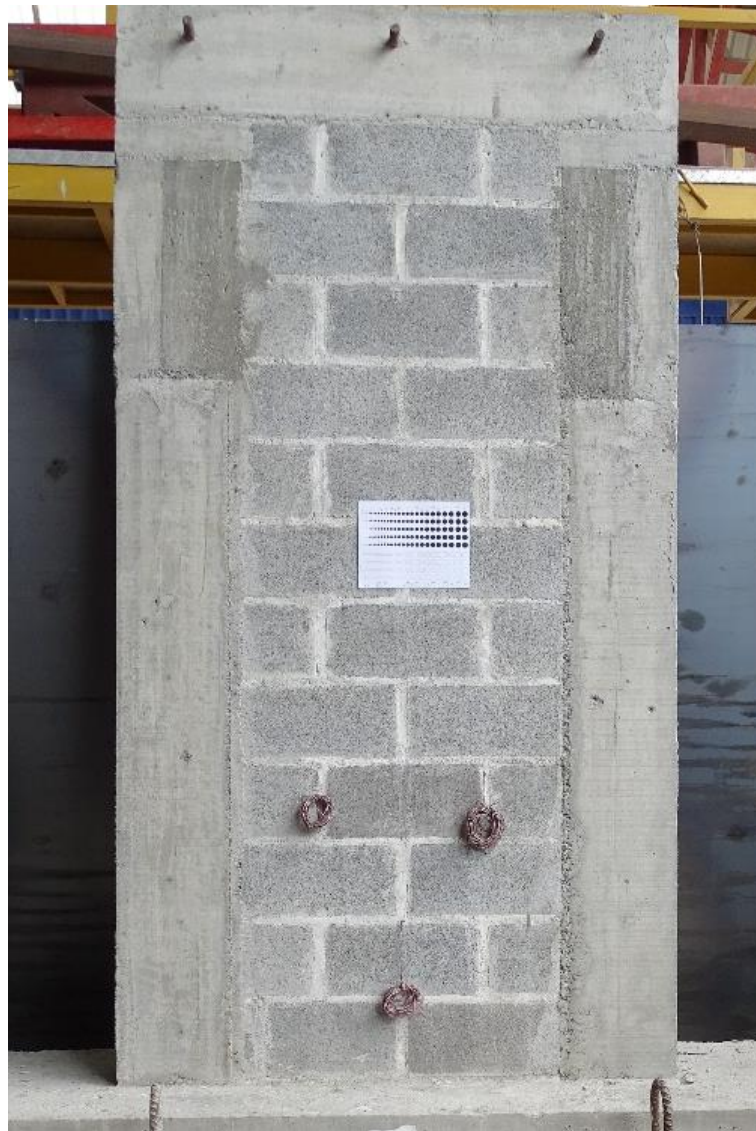
Imagen 46. Colocación del patrón regular experimental en la cara del muro.
