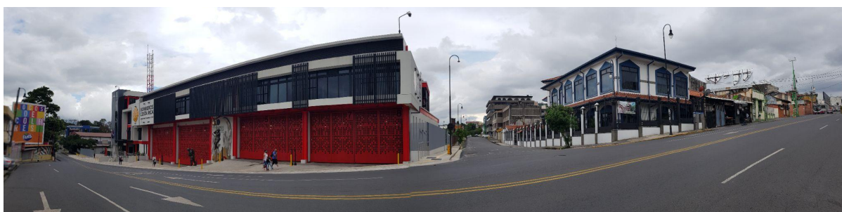
Figura 19. Calle central como eje articulador de transporte público y privado, distrito Carmen.
