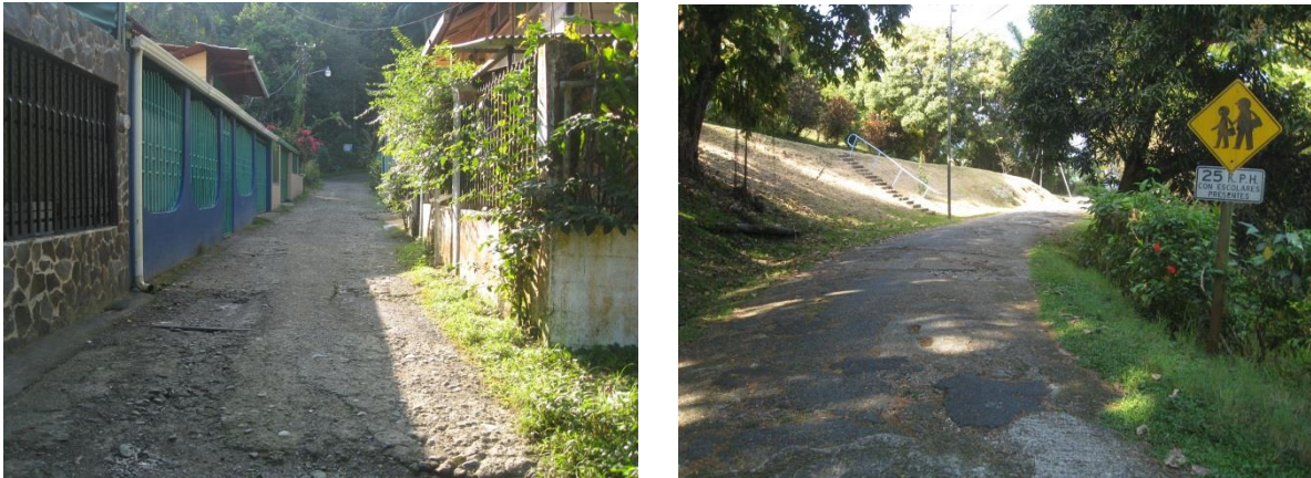
Fotografías 1 y 2. Estado de calzada en algunos sectores de la Zona Americana y Zona 0.
