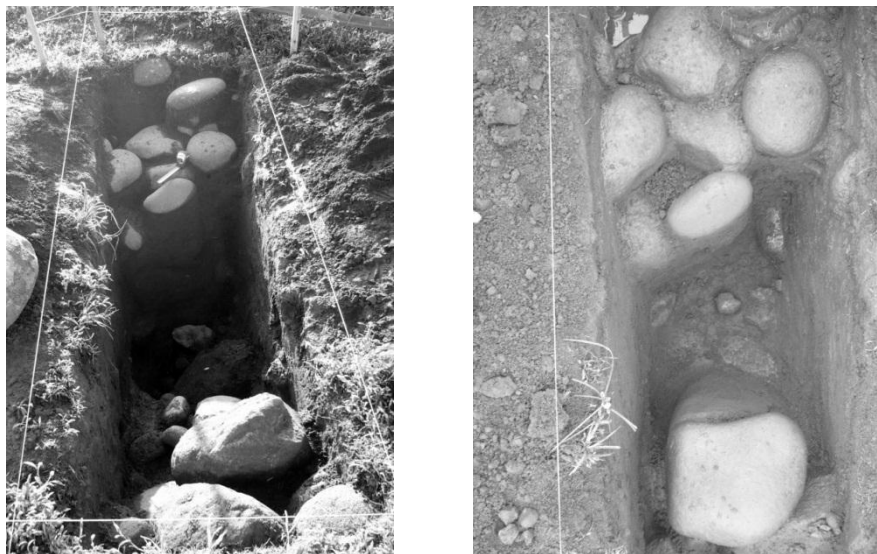
Figura A2.35. Vista de la trinchera 18 (izquierda) y detalle del drenaje (derecha).
